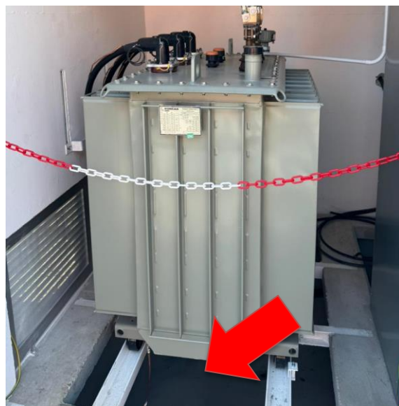
Slika 9. Podni otvor za prihvat iscurjelog ulja
