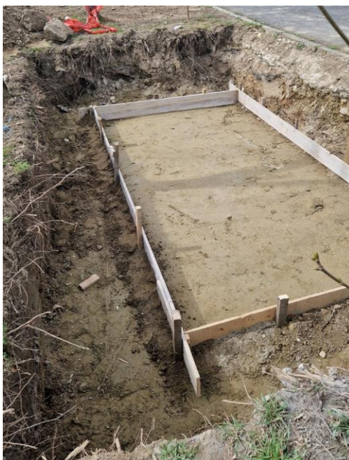
Slika 6. Priprema i iskop temelja
