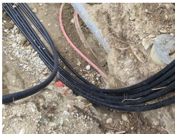
Slika 20. Kabel NA2XS(F)2Y (1x185RM/25mm 2 ) položen u kabljski rov
