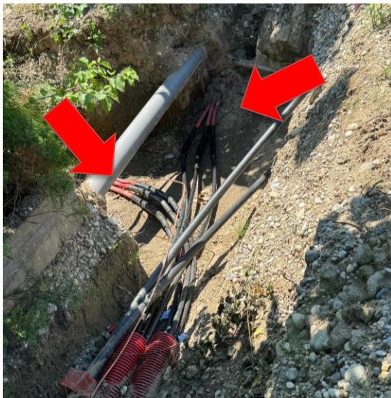
Slika 23. SN kableski vod nakon spajanja (1)
