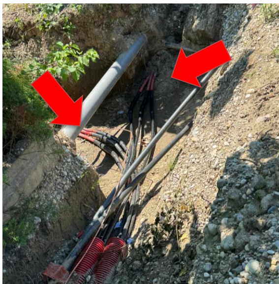
Slika 23. SN kableski vod nakon spajanja (1)
