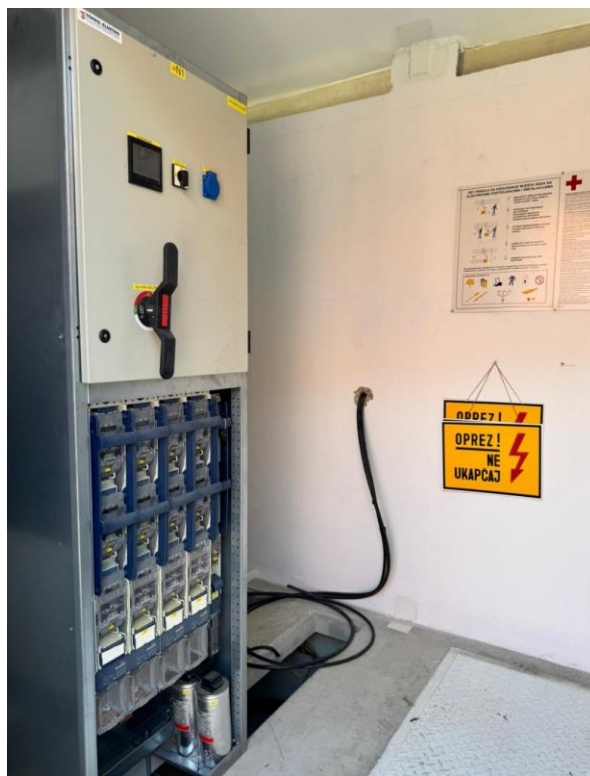
Slika 16. NN sklopni blok 1NBO-6-SS-1600
