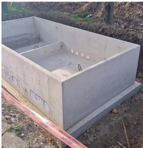
Slika 7. Armiranobetonski temelj u obliku kompaktne kade
