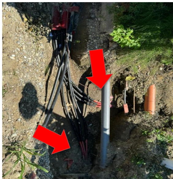
Slika 24. SN kableski vod nakon spajanja (2)
