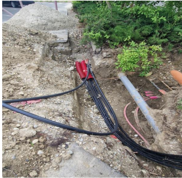
Slika 22. SN kableski vod prije spajanja
