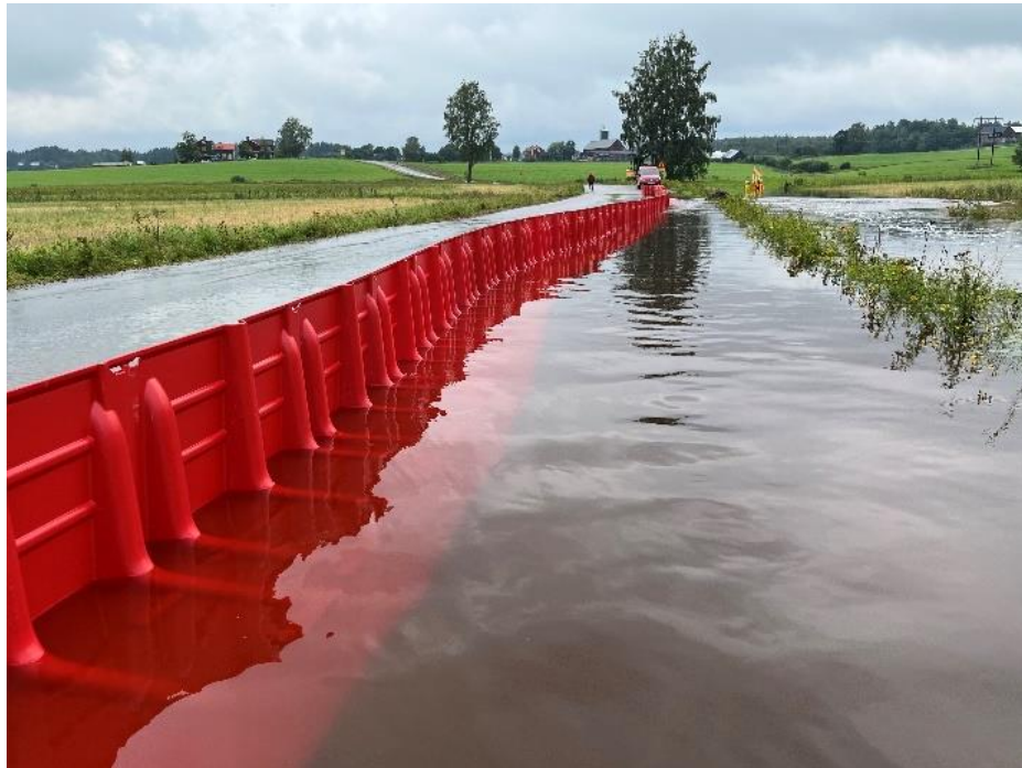
Slika 14 Boxwall poplavna barijera [14]
