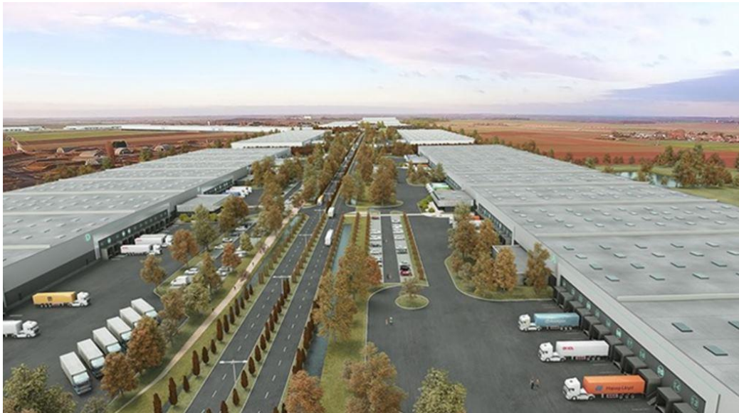
Slika 1 Izgradnja kompleksa e-Valley [1]
