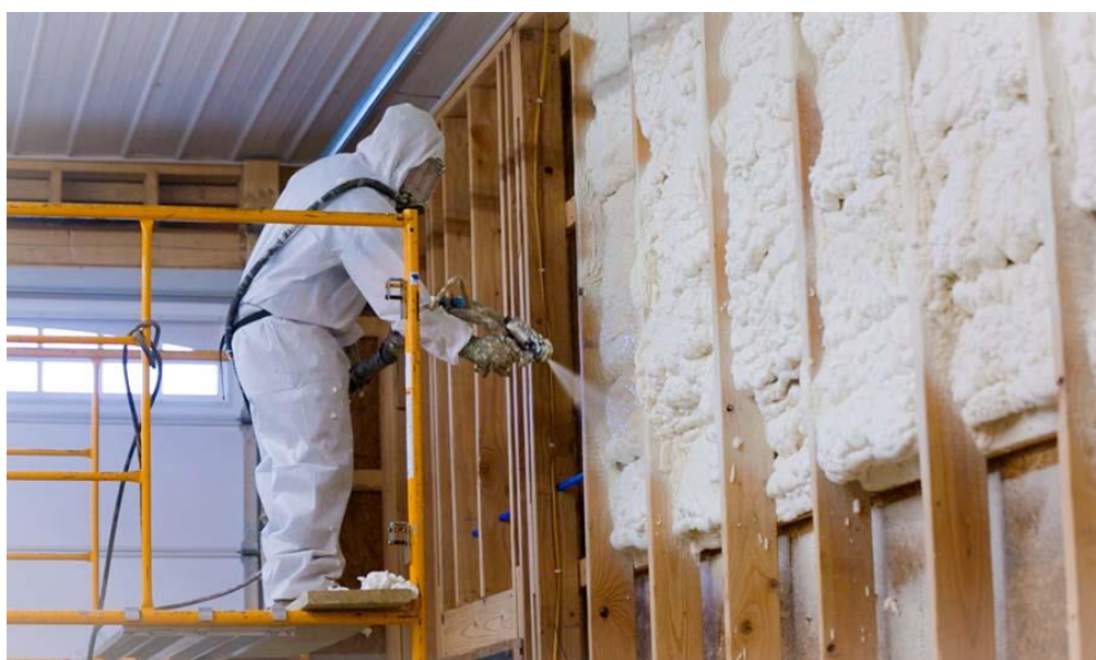
Slika 4.2.7. Nanošenje prskanjem
