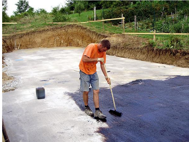
Slika 9.2.2. Nanošenje bitumenskog prednamaza
