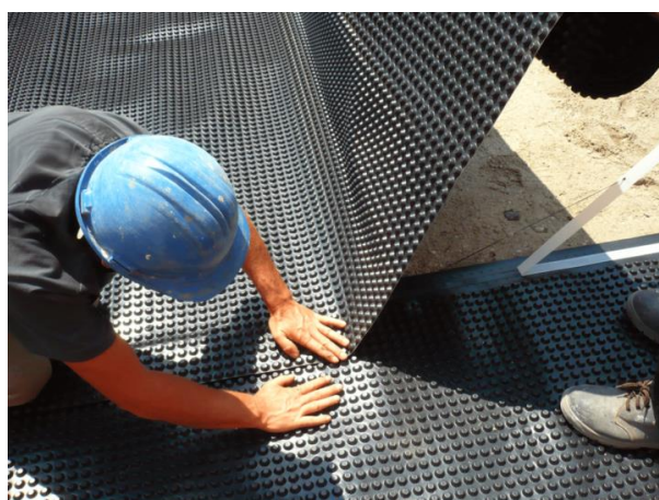
Slika 9.5.1. Postavljanje čepaste folije
