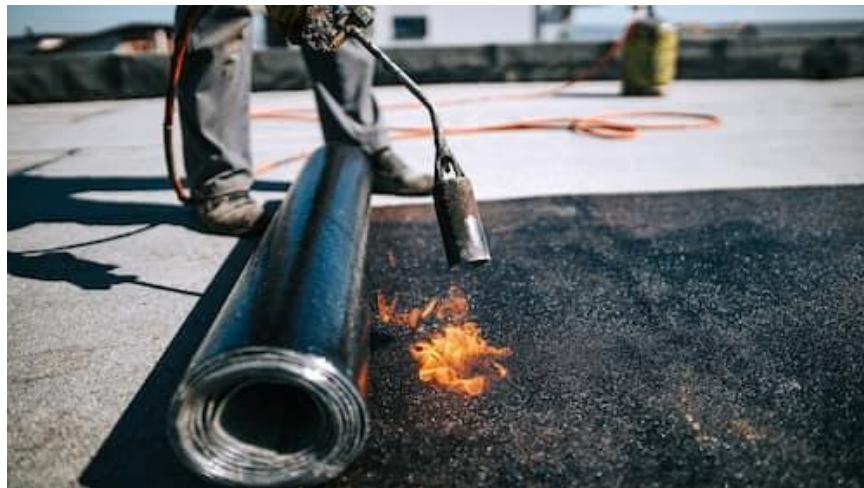
Slika 9.2.3. Polaganje ljepenke otvorenim plamenom
