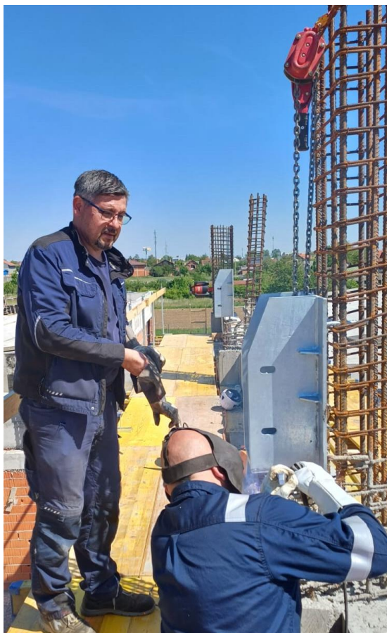
Slika 31. - Postavljanje čeličnih ležajeva za LLD nosače
