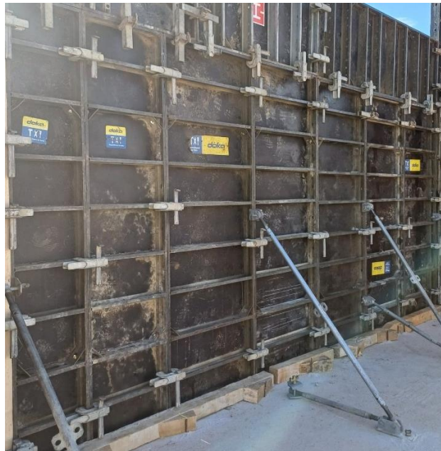
Slika 36. – Oplata AB zida
