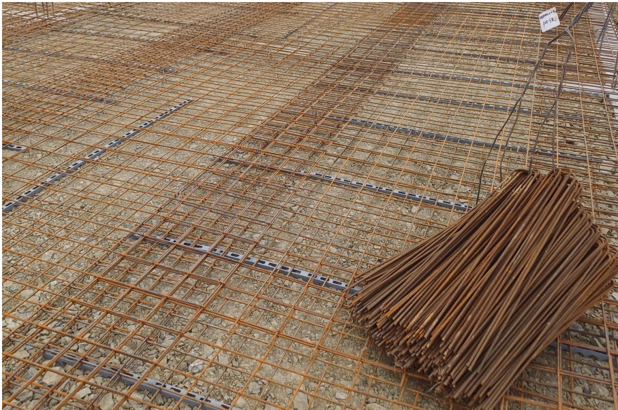
Slika 25. - Postavljanje mreža podne ploče preklop 3 okna
