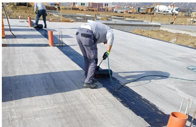
Slika 41. - Zavarivanje polimerbitumenske trake
