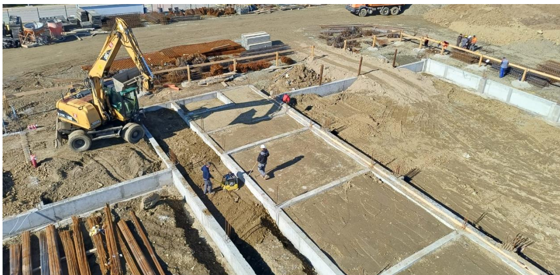
Slika 14. - Izrada nasipa između nadtemelja
