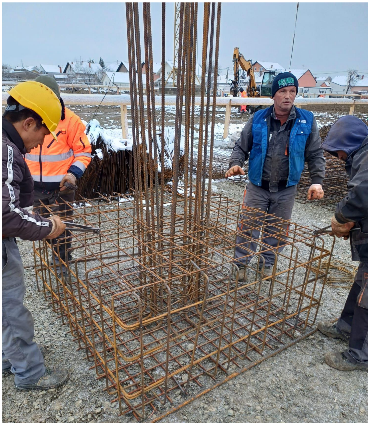
Slika 24. - Vezivanje armature temeljne stope
