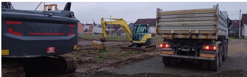
Slika 16. - Odvoz viška zemljanog materijala
