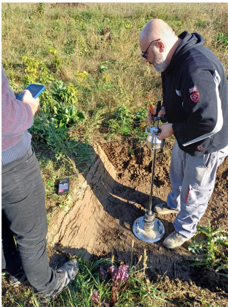
Slika 11. - Kontrola temeljnog tla sa dinamičkom kružnom pločom
