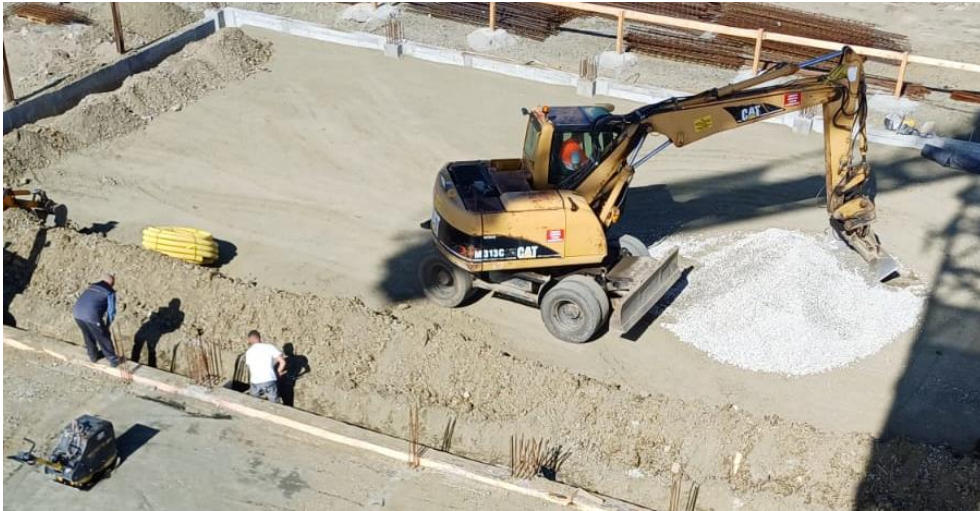
Slika 15. - Izrada drenaže dvorane
