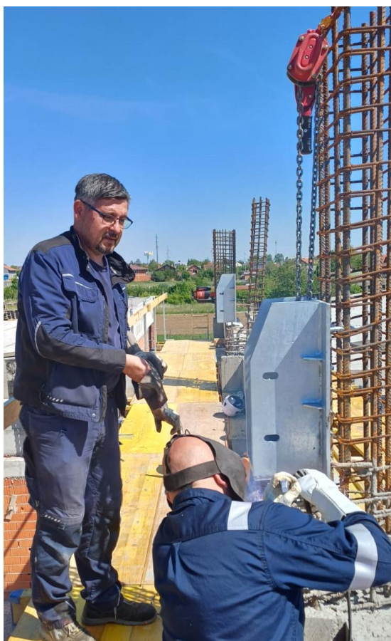
Slika 31. - Postavljanje čeličnih ležajeva za LLD nosače
