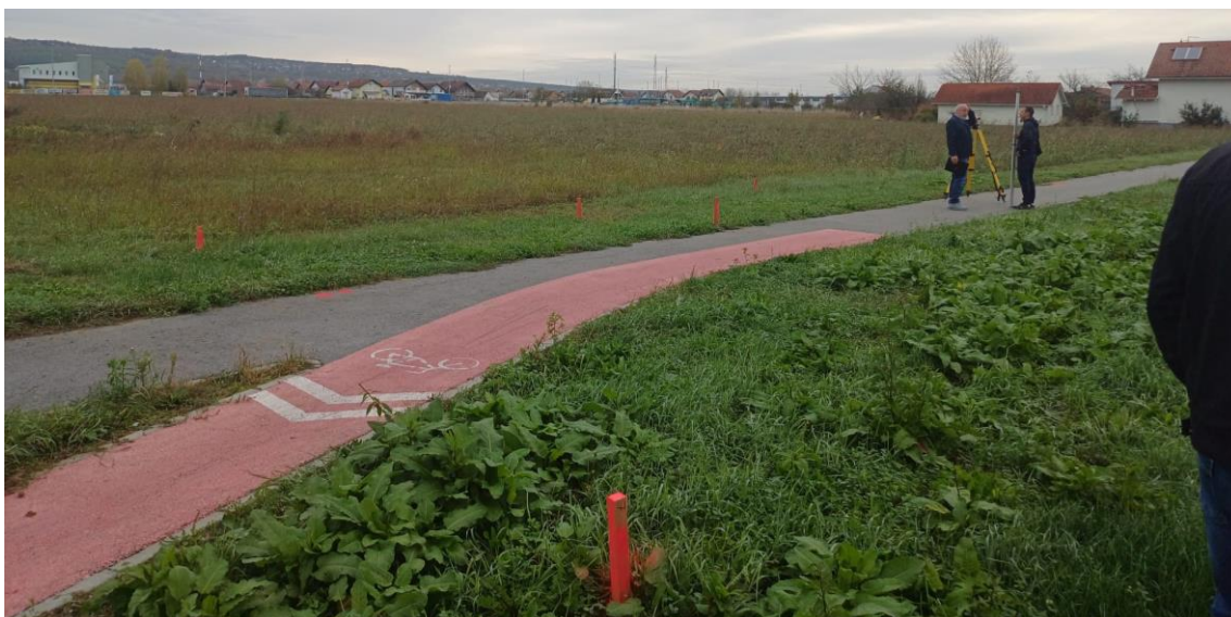
Slika 6. - Iskolčenje zgrade
