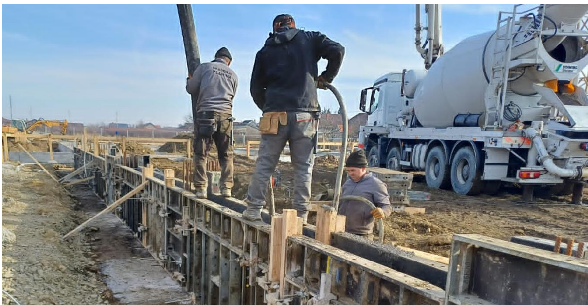
Slika 18. - Betoniranje AB nadtemeljnih greda
