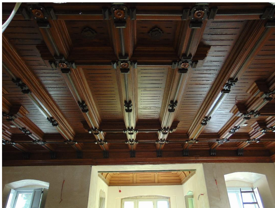
Slika 16. Strop u jednoj od prostorija dvorca Opeka
