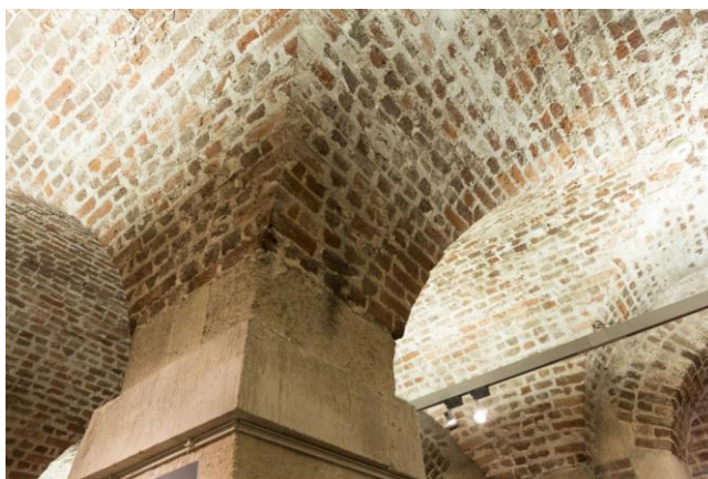
Slika 3.3 Korištenje vapnenog morta za obnovu svoda povijesne građevine [11]
