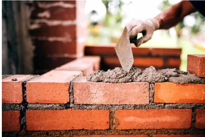
Slika 3.1 Zidanje mortom na bazi cementa [8]
