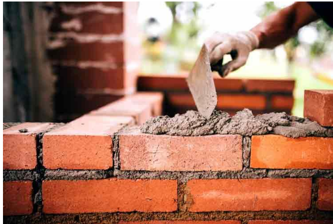
Slika 3.1 Zidanje mortom na bazi cementa [8]
