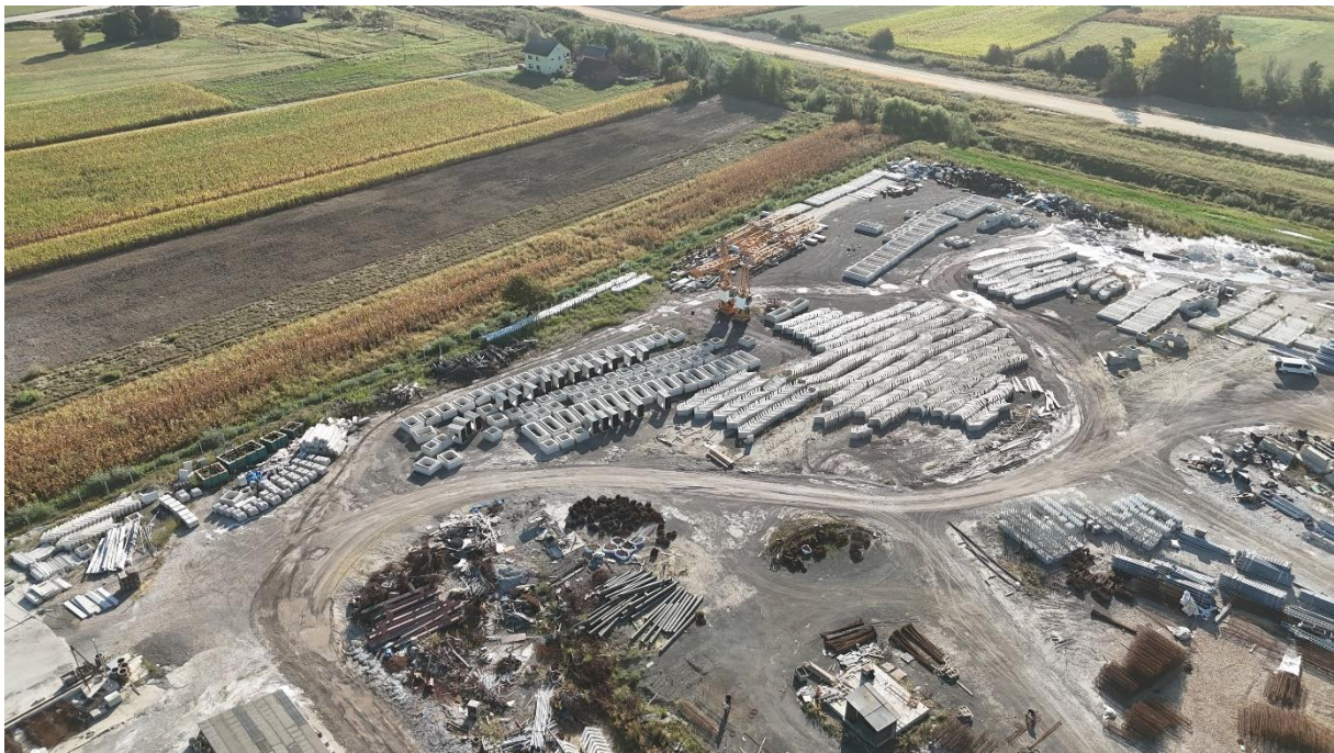
Slika 27. Otvoreno skladište građevinskog materijala tvrtke Cengiz Insaat Hrvatska
