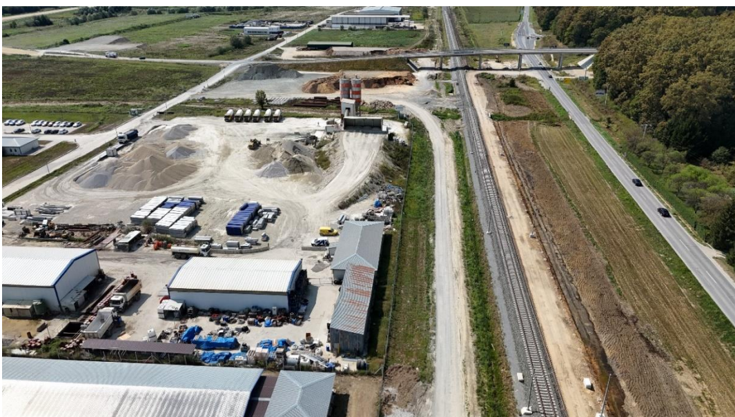
Slika 25. Depniji kamenog i zemljanog materijala i betonska centrala u bazi tvrtke
