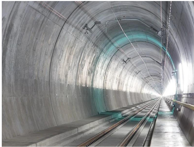
Slika 2. Tunel St. Gothard u Švicarskoj
