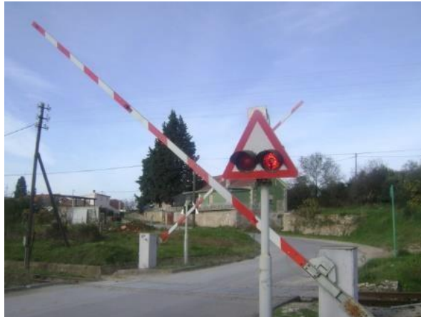
Slika 3. Željezničko - cestovni prijelaz
