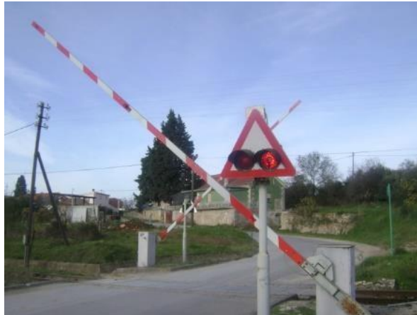
Slika 3. Željezničko - cestovni prijelaz
