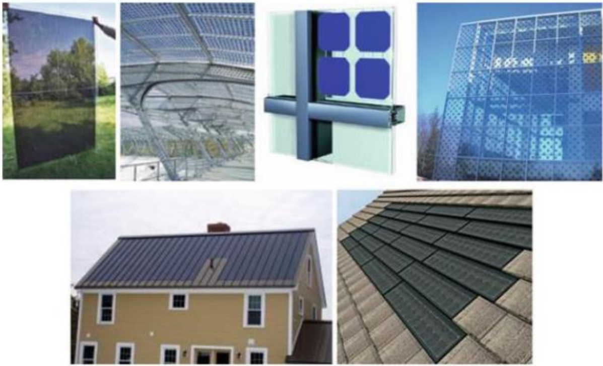
Slika 17. Prikaz različitih rješenja integracije FN modula [25]
