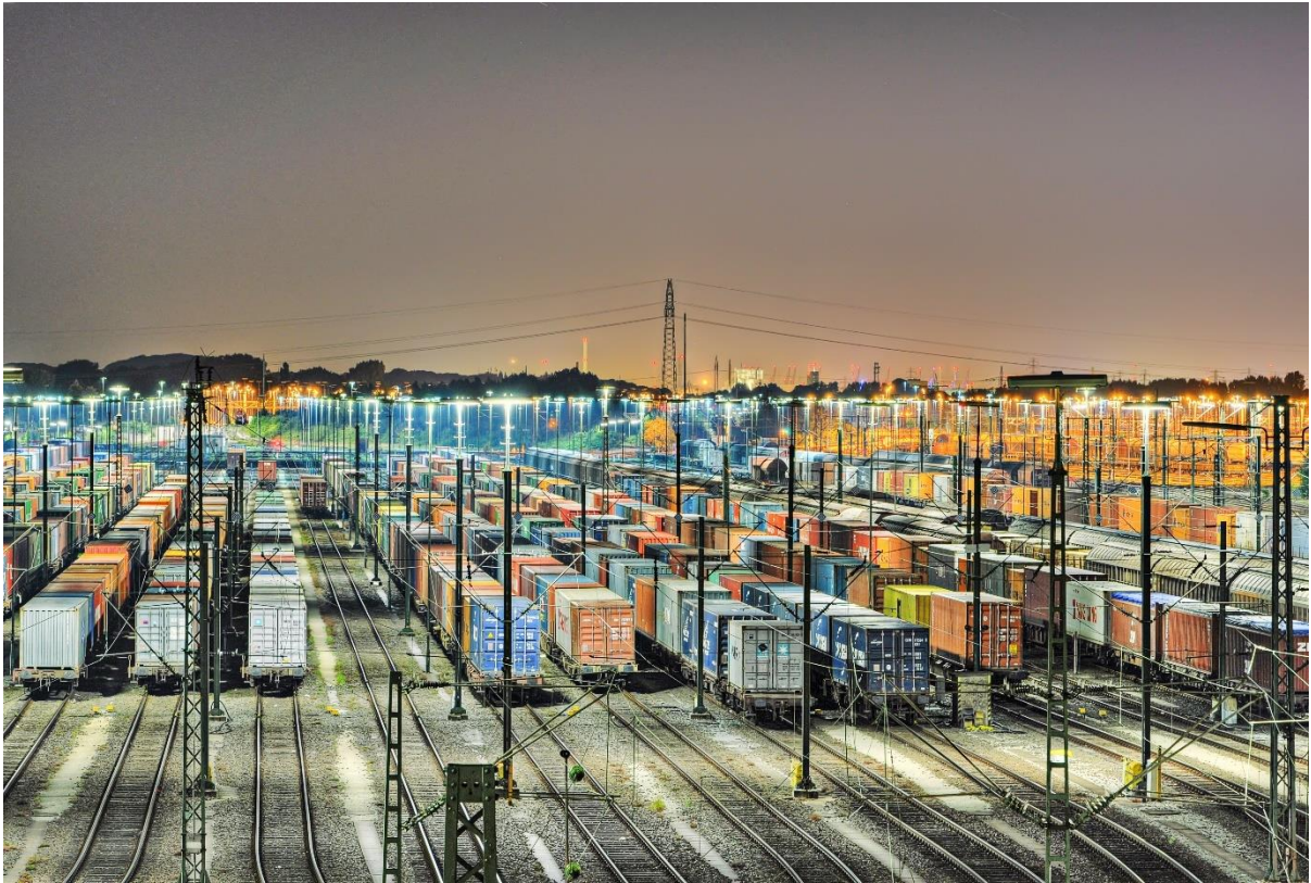
Slika 11 - Dio terminala Ostrava-Paskov u Češkoj Republici
