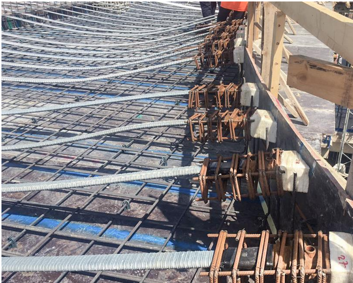
Slika 2.3 Prikaz „bonded“ kabela za naknadno prednapinjanje (Izvor: [7])
