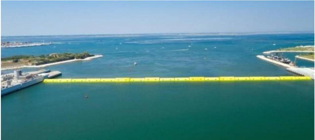
Slika 23: Mobilne barijere sustava MOSE [19]
