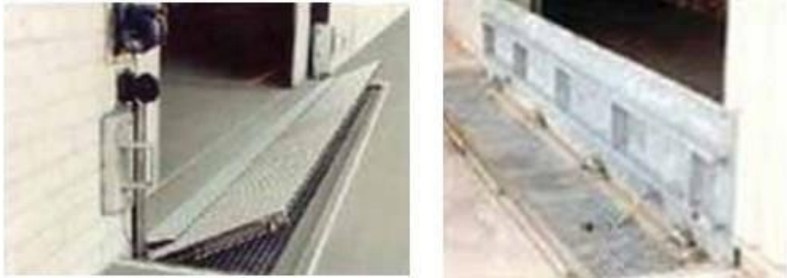
Slika 18: Spuštajuće vodene pregrade [13]
