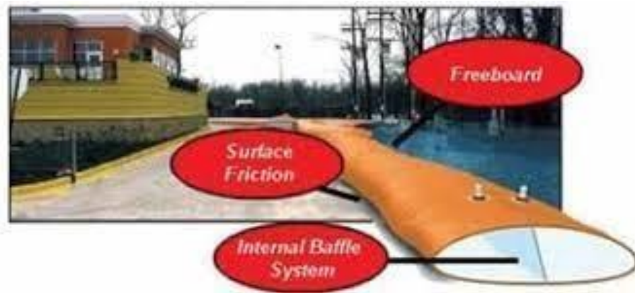
Slika 13: Vodena pregrada punjena vodom [13]
