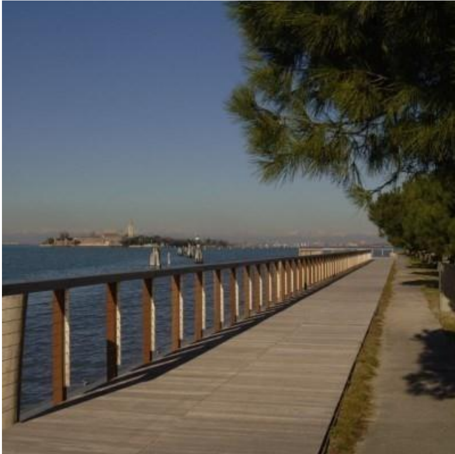
Slika 24: Lokalne mjere obrane od poplave u naselju [19]
