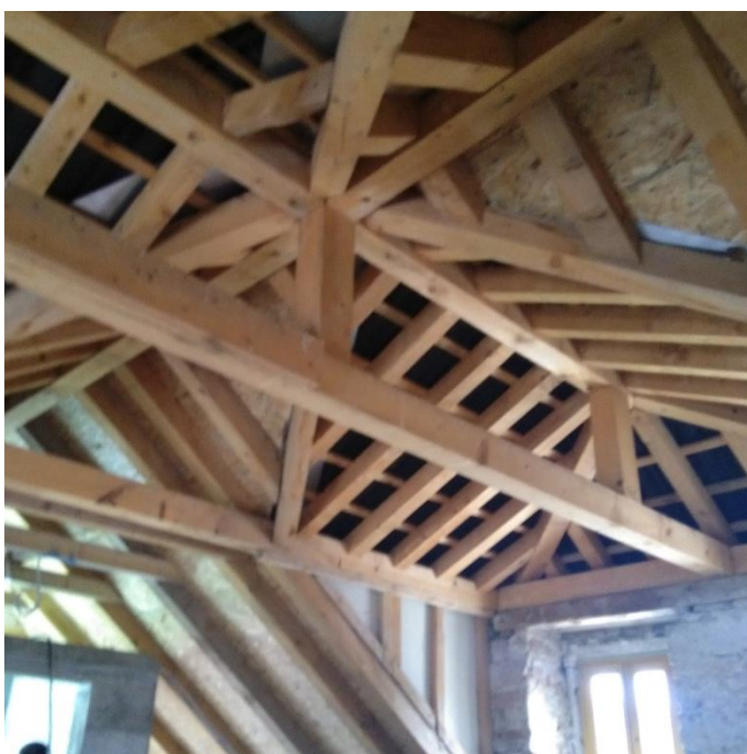
Slika 77. Prikaz sanacije kompleksnog krovišta
