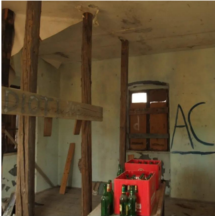
Slika 19. Podbočenja u prostoriji na prvom katu
