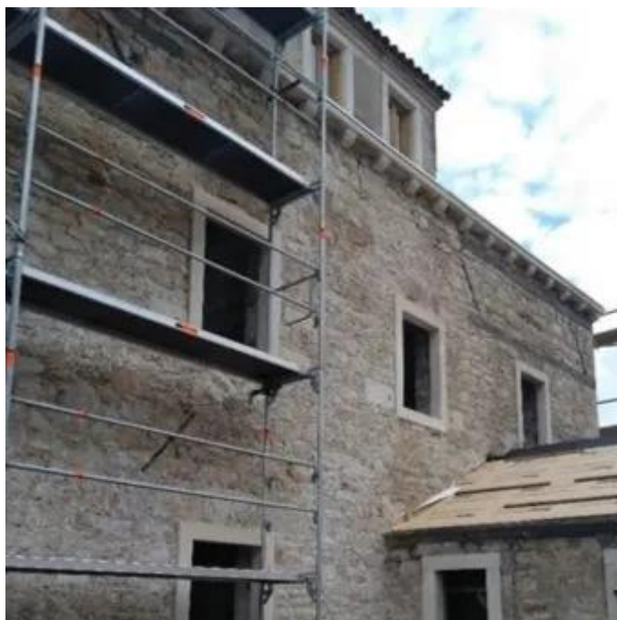
Slika 81. Ojačanje horizontalnim serklažima na rubovima
