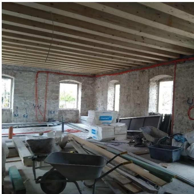
Slika 71. Prikaz novog drvenog gredniika
