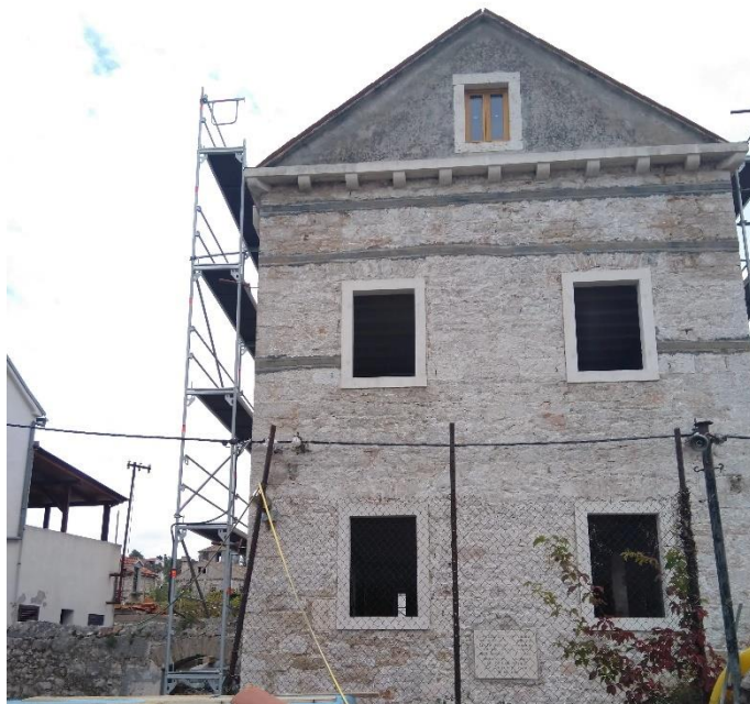
Slika 88. Spregnuti zidovi na gornjim etažama
