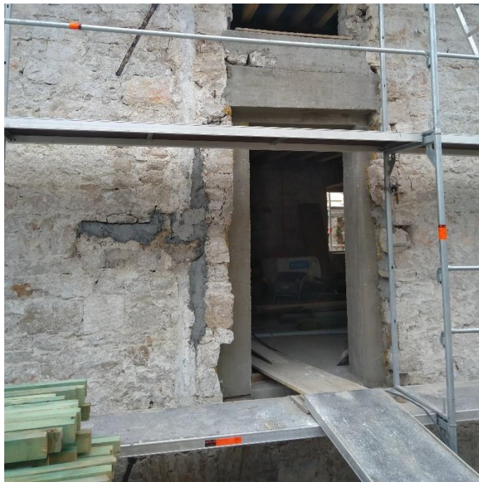
Slika 87. Ojačanje otvora
