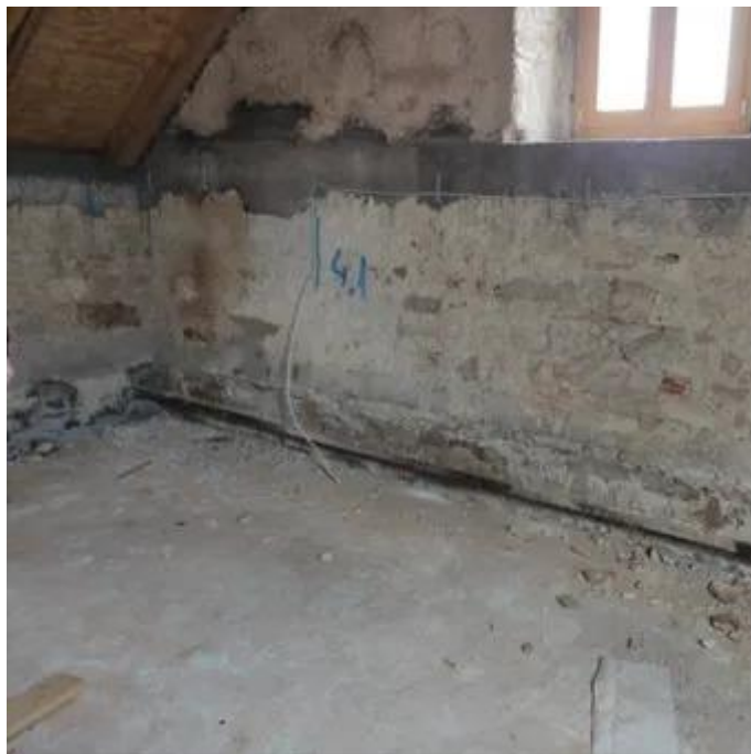
Slika 91. Betoniran zid atike
