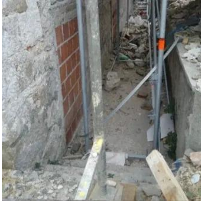
Slika 86. Zazidavanje starih otvora
