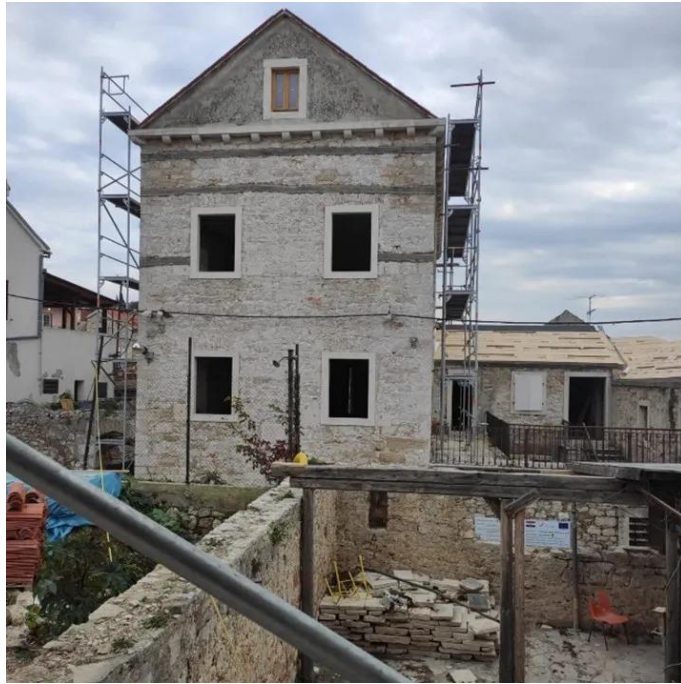
Slika 94. Uklonjena stara fasada
