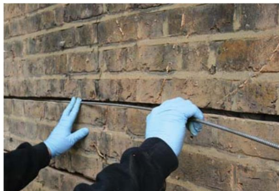
Slika 66. Postava čeličnih šipki u nove fuge
