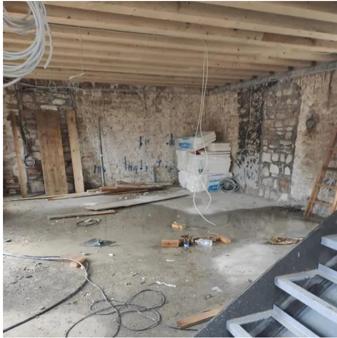
Slika 92. Zatvoreni stari otvori
