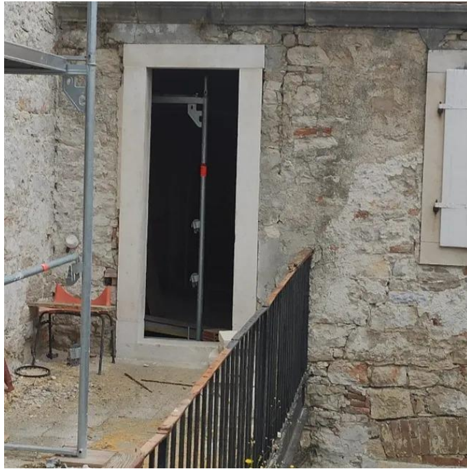
Slika 90. Početak sanacije otvora
