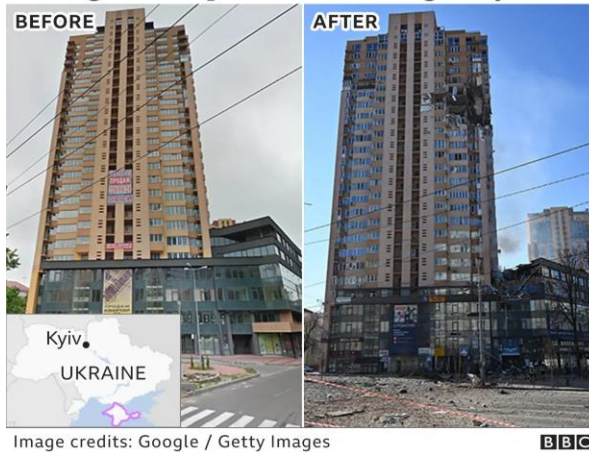
Slika 5. Oštećenje stambene zgrade u Kijevu (izvor: BBC News)
