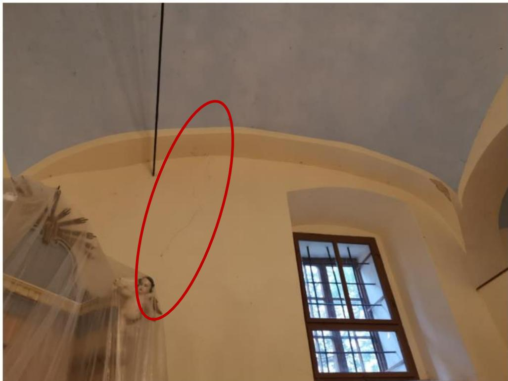
Slika 36: Pukotine na sjevernom pročelju i stropu
