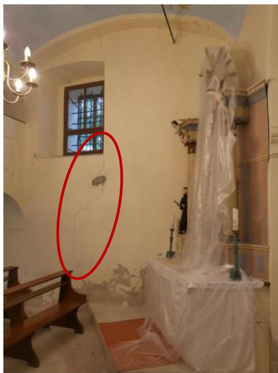
Slika 35: Pukotine ispod prozora na sjevernom pročelju
