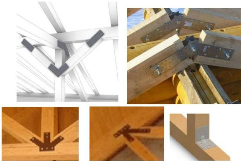
Slika 50: Primjer ojačanja neadekvatnih spojeva drvene konstrukcije [7]
