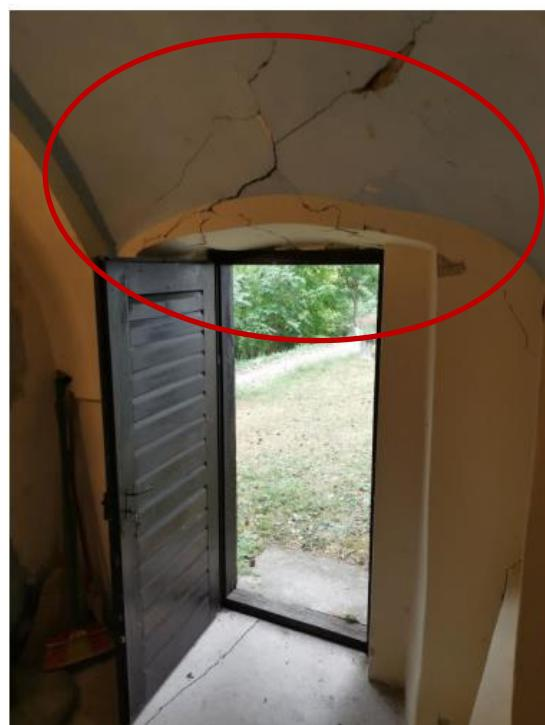
*Slika 39: Pukotine na svodu ulaznog prostora
