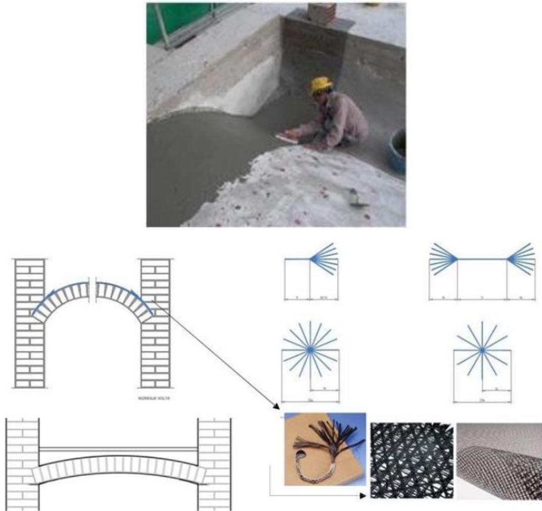
Slika 62: Primjer i prikaz FRCM sustava – prekrivanje kupole [7]
