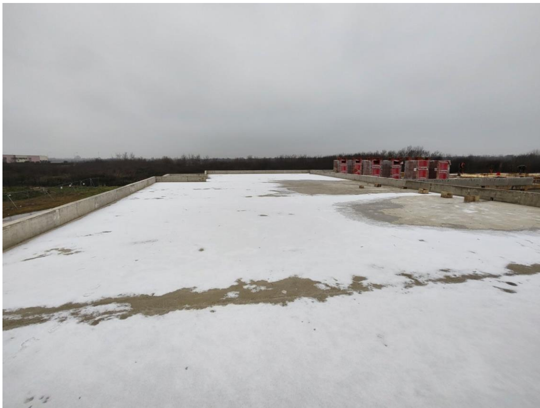
Slika 18. Prikaz nepovoljnih vremenskih uvjeta u fazi izvođenja radova ravnog krova
