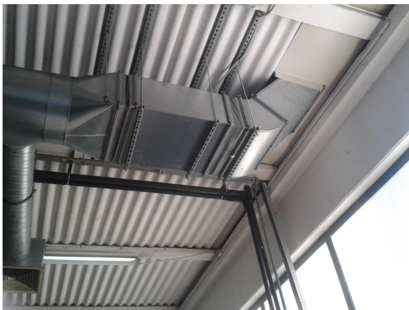
Slika 7.5 Apsorpcijski prigušivač zvuka
