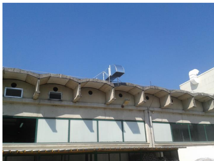
Slika 7.5 Apsorpcijski prigušivač zvuka
