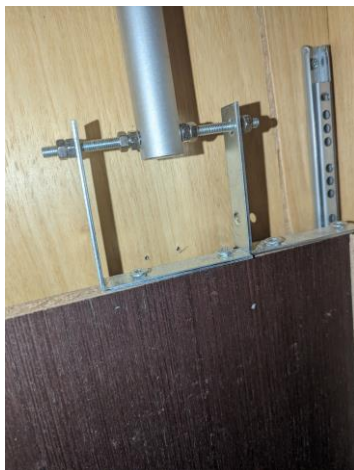
Slika 3.3. Kutnici montirani na vrata
