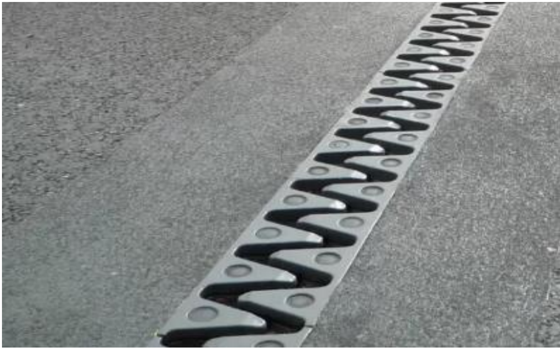
Slika 23 Jednoprofilna prijelazna naprava sa polimer betonom, [4]
