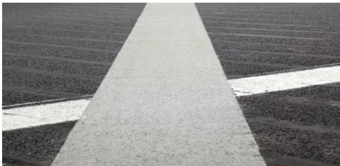
Slika 20 Poliuretanska kontinuirana prijelazna naprava, [4]
