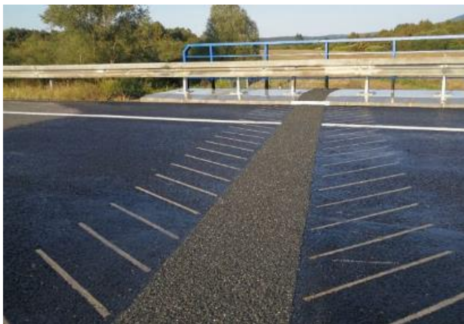
Slika 18 Bitumenska kontinuirana prijelazna naprava, [4]
