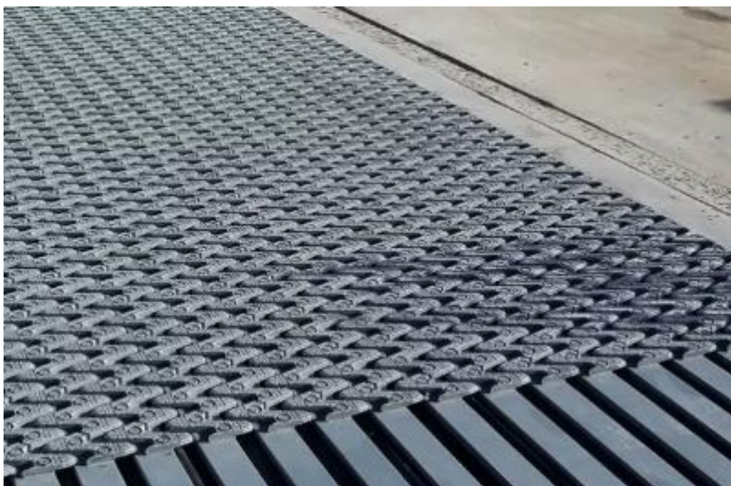
Slika 29 Modularna prijelazna naprava, [4]
