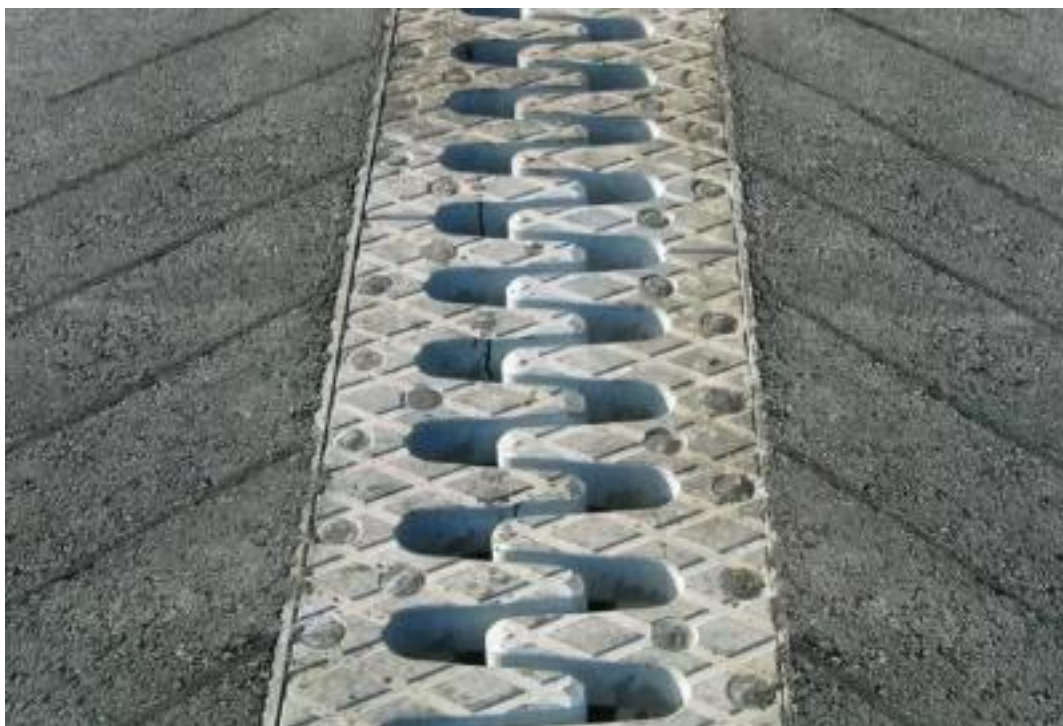
Slika 27 Čelična češljasta prijelazna naprava, [4]
