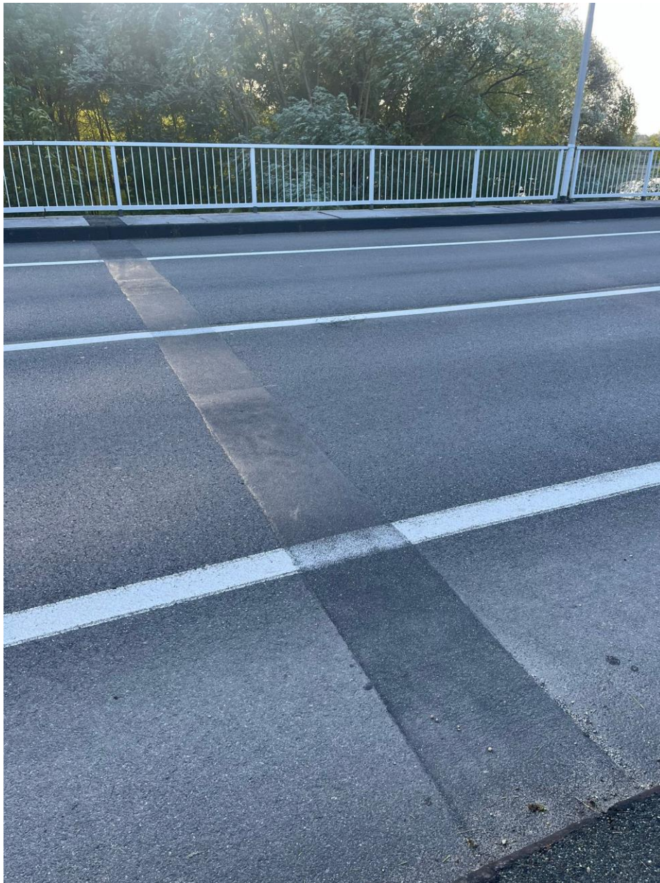
Slika 39 Bitumenska kontinuirana prijelazna naprava na mostu u Varaždinu, (10.10.2024.)
