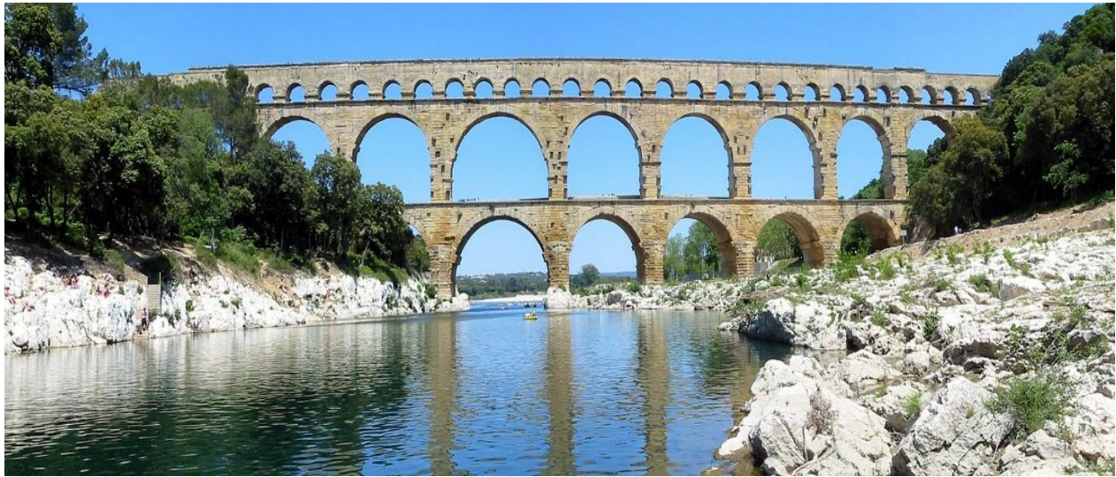
Slika 2. Most Pont du Gard [3]
