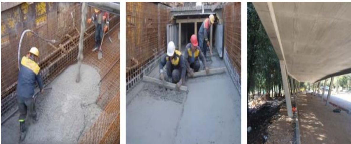
Slika 7. Lijevanje i ravnanje svježeg betona te izgled stvrdnutog betona konstrukcije [7]
