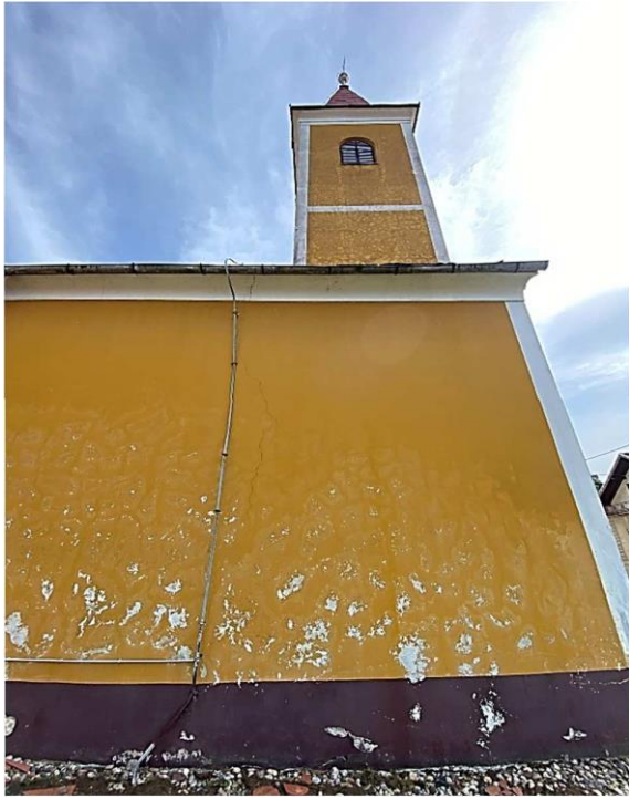
Slika 35. Vertikalna pukotina sjevernog pročelja
