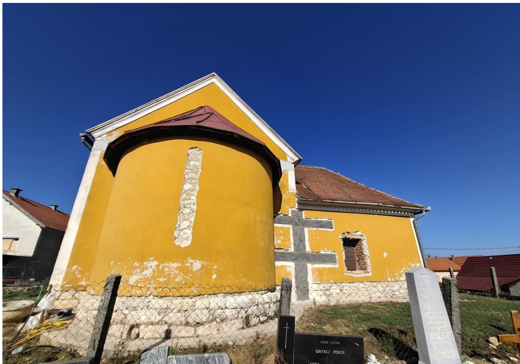
Slika 13. Prikaz istočnog pročelja
