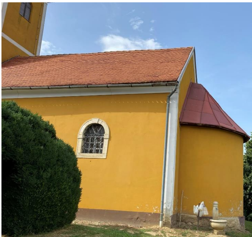
Slika 11. Prikaz južnog pročelja
