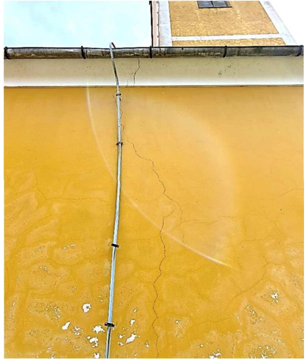
Slika 35. Vertikalna pukotina sjevernog pročelja
