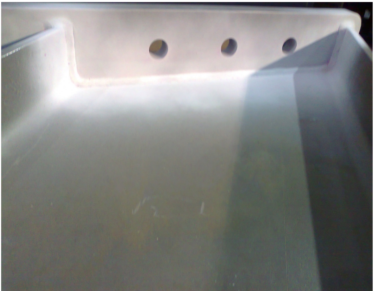
Slika 9. 27 Završna slika penetrantske kontrole zavara
