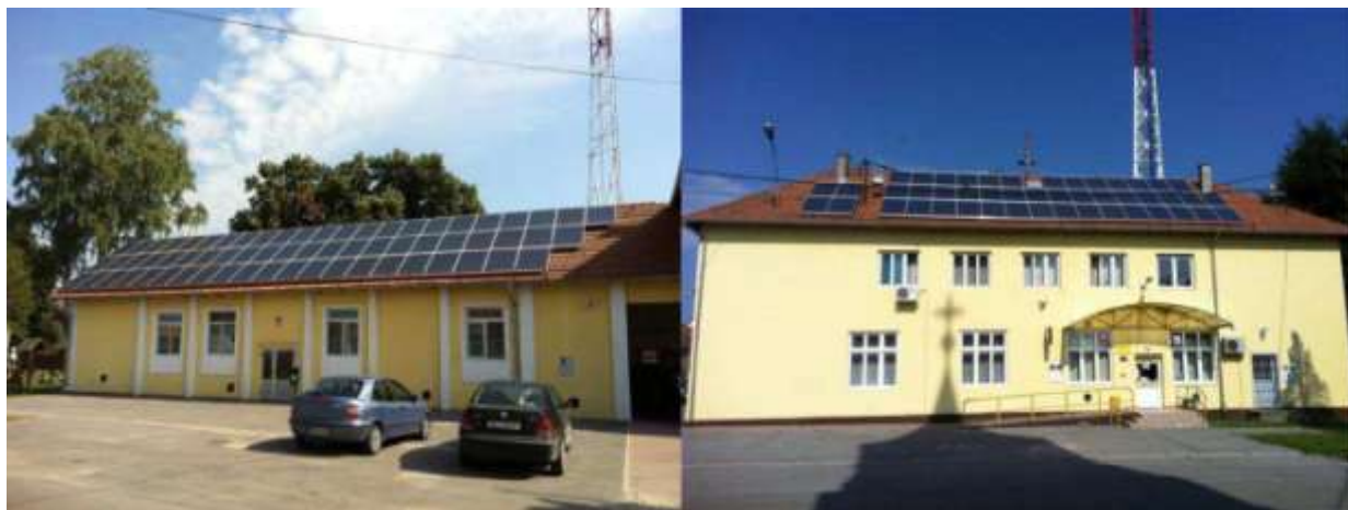
SLIKA 4.1. Prikaz predmetne solarne elektrane (desna strana - južni krov, lijeva strana - istočni krov)
