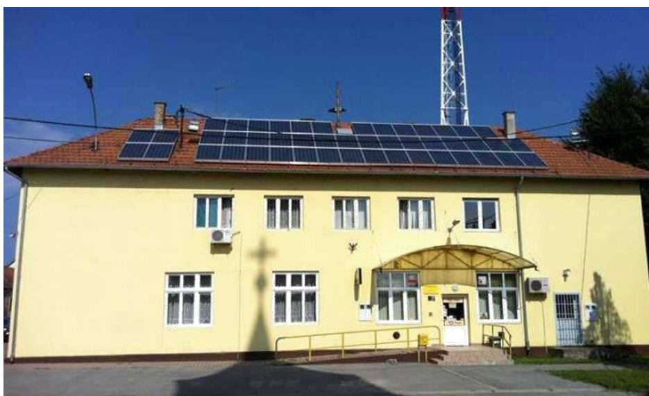
SLIKA 6.3. Fotonaponski moduli predmetne SE postavljeni na krovu okrenuti prema istoku [16]
