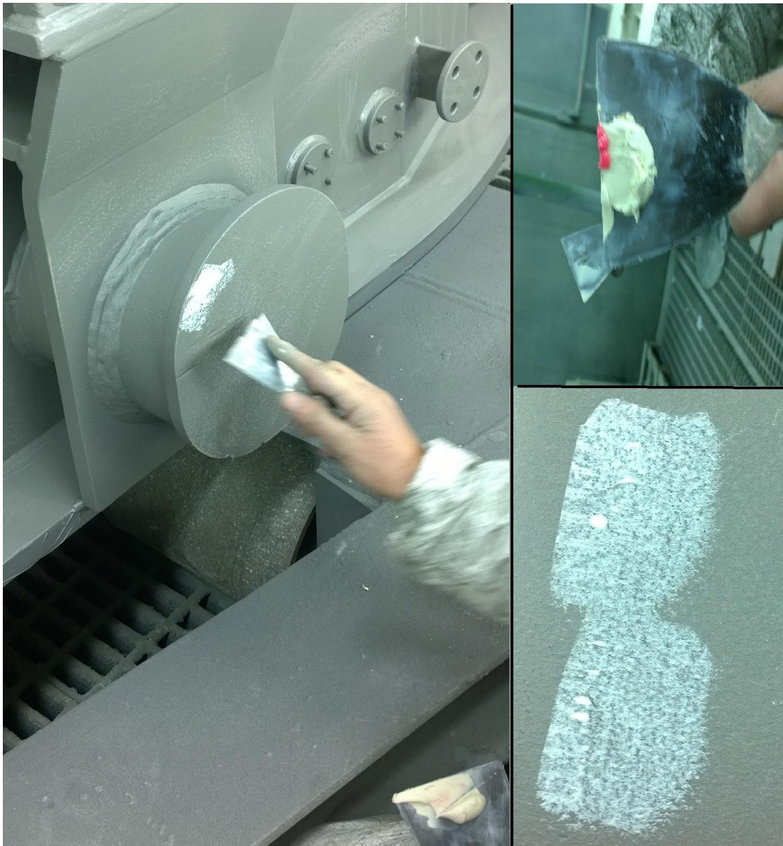
Slika 6.18 Popravljanje grešaka kitom
