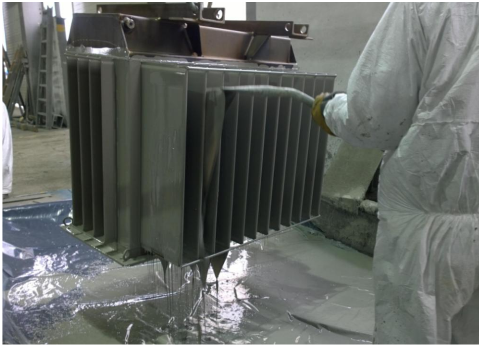
Slika 5.20 Nanošenje boje prelijevanjem
