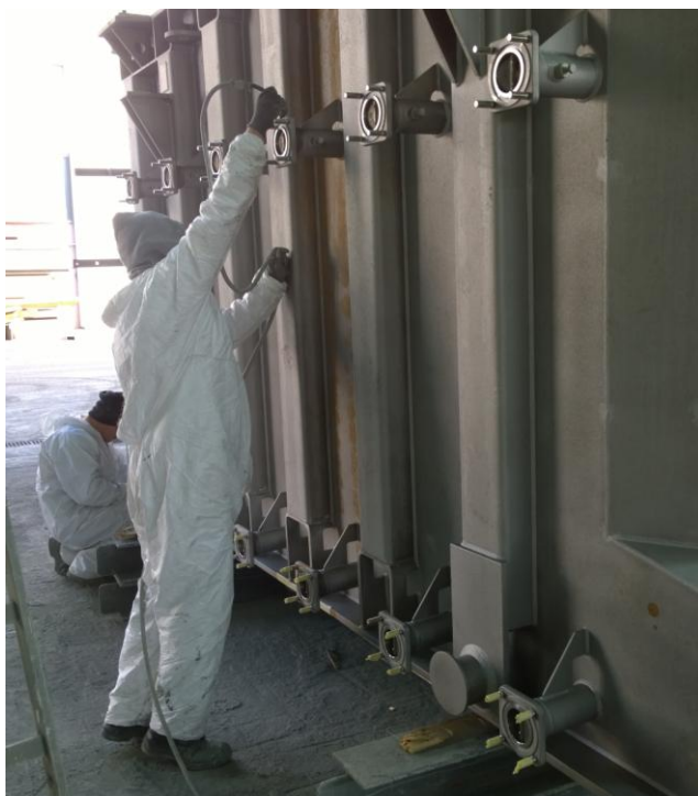
Slika 6.7 Ispuhivanje zrakom
