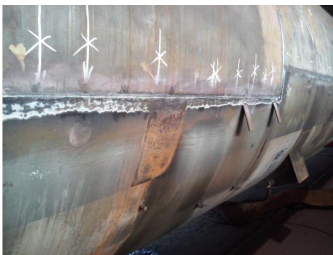
Slika 33. Izgled zavarenih spojeva nakon sanacije pogrešaka s vanjske strane spremnika
