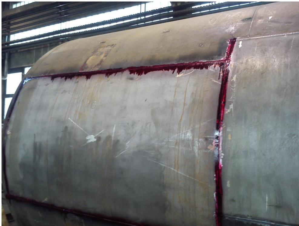
Slika 29. Naneseni penetrant na zavarenim spojevima
