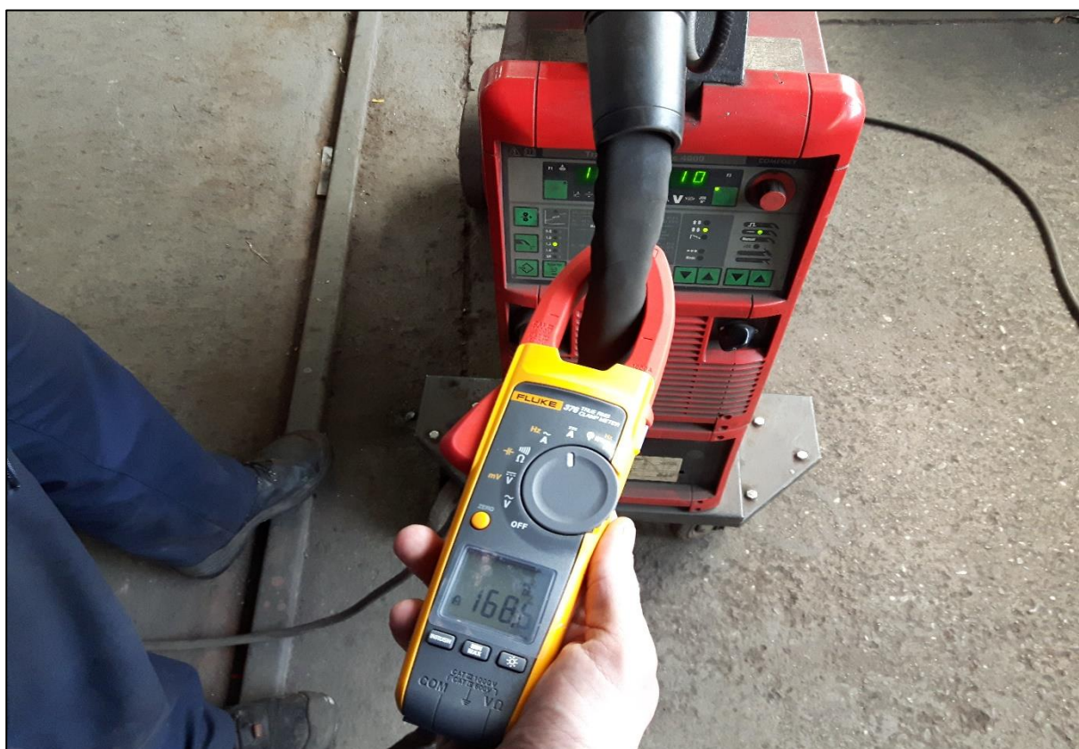
Slika 9.4 Mjerenje struje zavarivanja obuhvatnim ampermetrom (strujnim kliještima)
