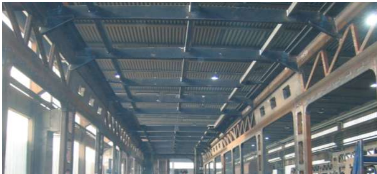
Slika 6.20 Konstrukcija krova nakon zavarivanja
