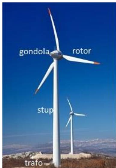
*Slika 4 Vjetroagregat sa označenim dijelovima*
