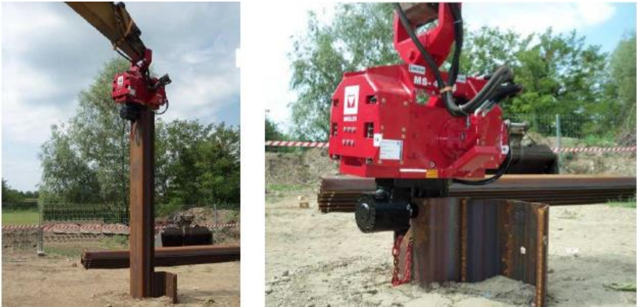
Slika 7. Vibrator za nabijanje i vađenje talpi
