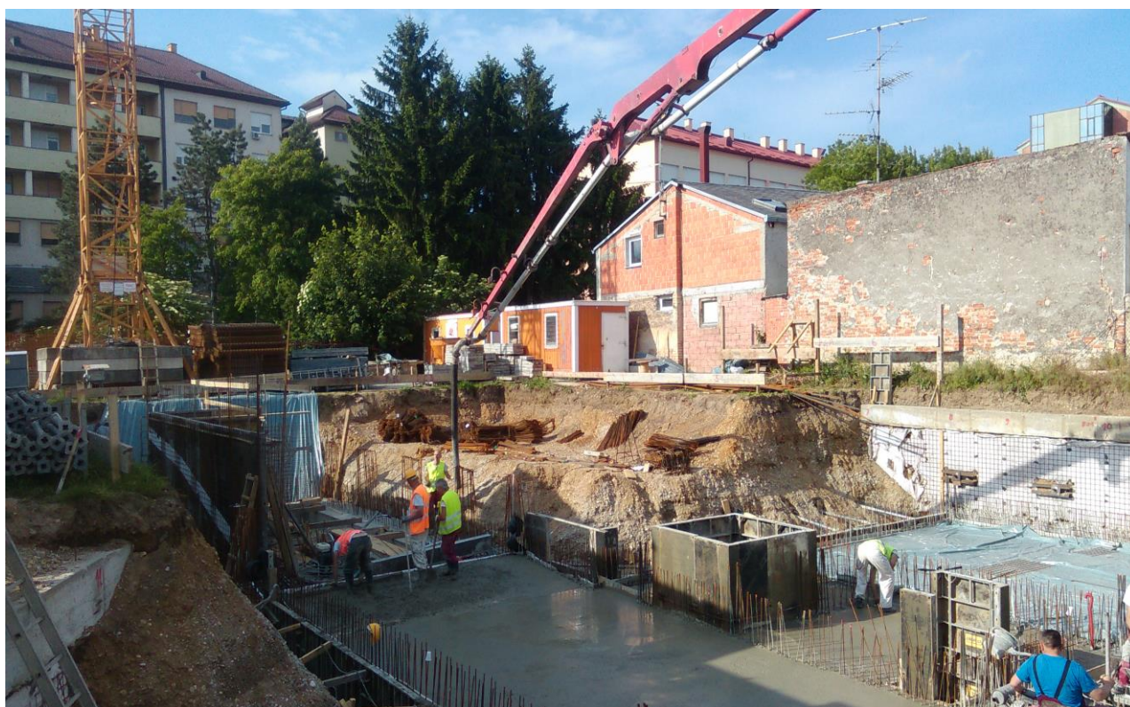
Slika 2. Građevna jama na predmetnoj lokaciji
