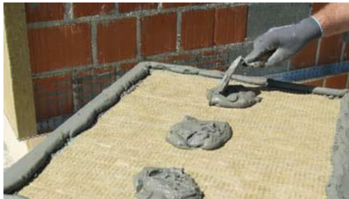
Slika 3.4.1. Građevinsko ljepilo na ploči od kamene vune
