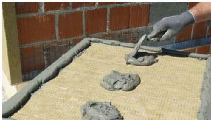
Slika 3.4.1. Građevinsko ljepilo na ploči od kamene vune
