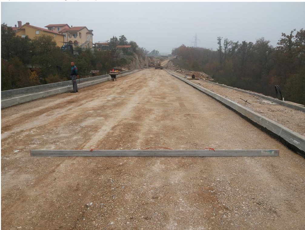
Slika 18. Ispitivanje ravnosti uređenog sloja tampona
