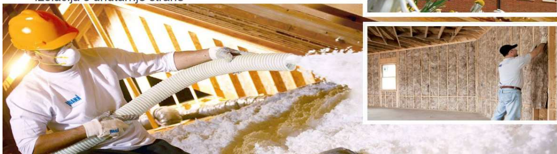
Slika 1.3 Primjeri primjene proizvoda tvrtke u građevinarstvu [8]
