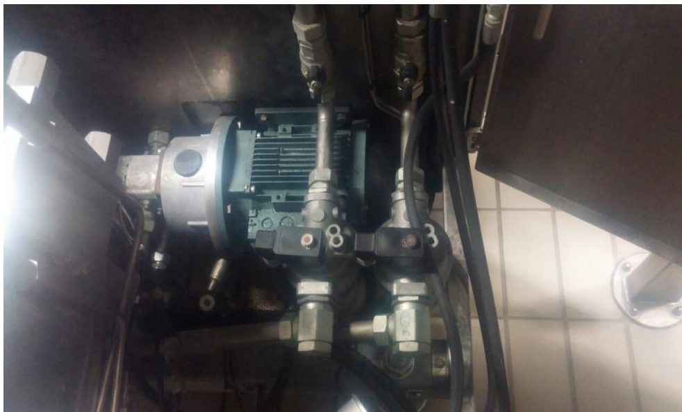
Slika 1.6 sustav za tlačno podmazivanje
