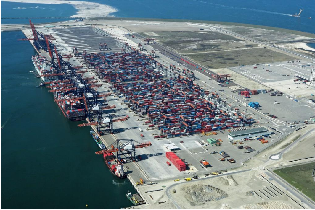
Slika 3.3.:Otvoreno skladište kontejnera u luci Rotterdam, Nizozemska [20]
