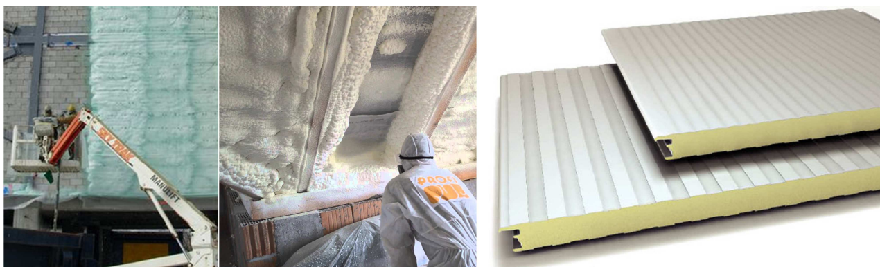
Slika 2.6 Štrcani poliuretan i paneli od poliuretana
