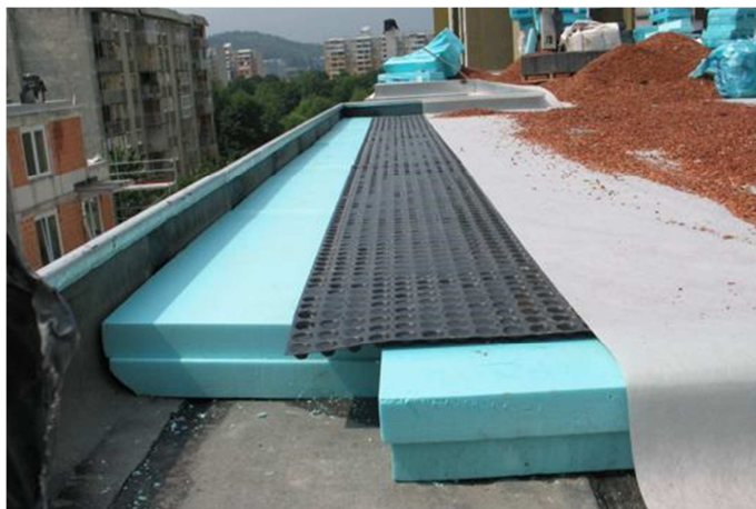
Slika 2.19 Ravni krov izoliran XPS pločama
