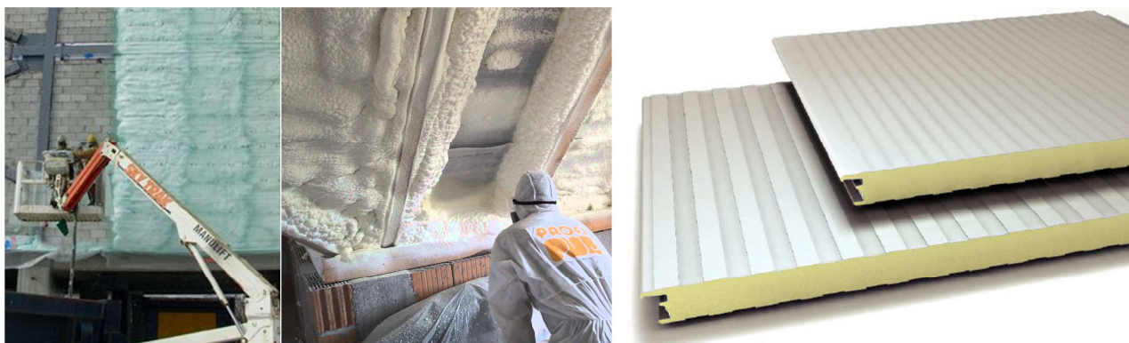
Slika 2.6 Štrcani poliuretan i paneli od poliuretana
