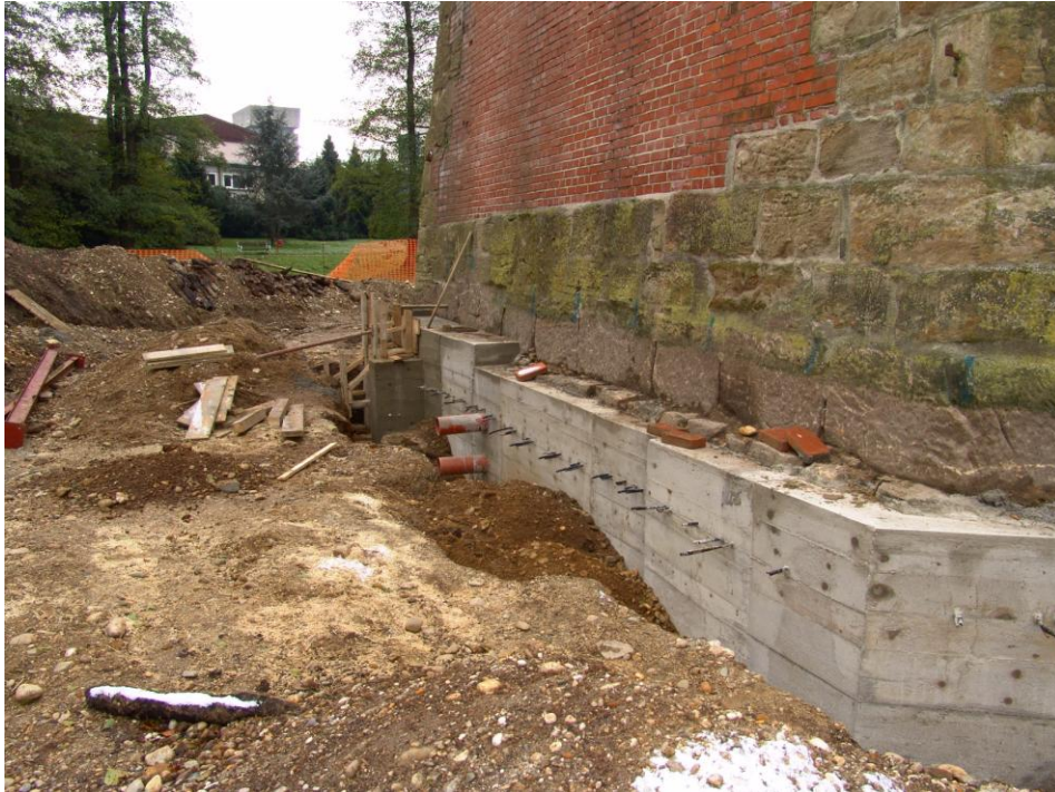
Slika 3.15. Sanacija peterokutnog bastiona
