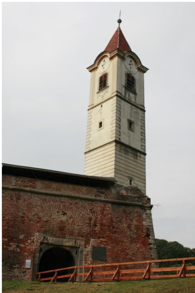
Slika 3.10. Glavni ulaz u bastion
