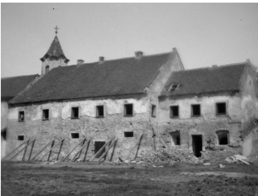
Slika 3.12. Srušena građevina iz 18.st.
