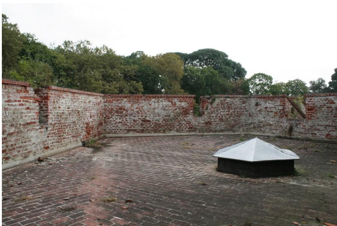
Slika 3.4. Nenatkrivena terasa SZ bastiona
