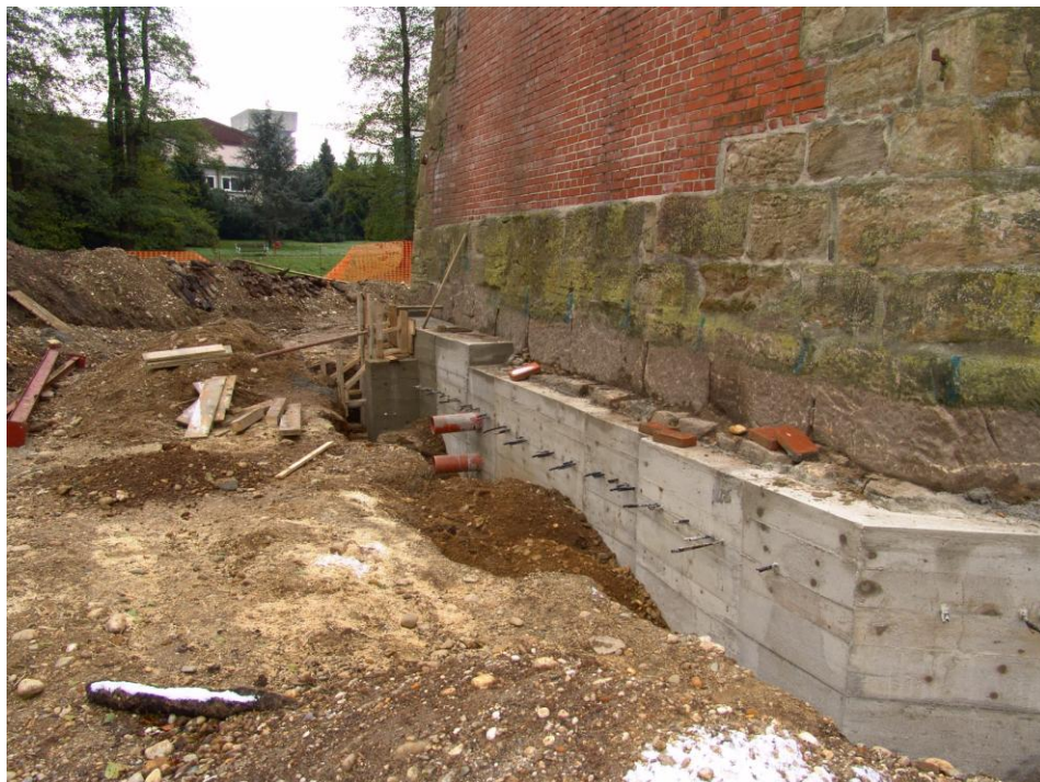
Slika 3.15. Sanacija peterokutnog bastiona
