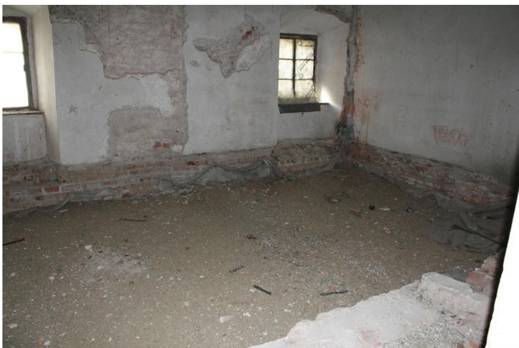
Slika 4.12. Pod prostorije na katu III.dilatacije
