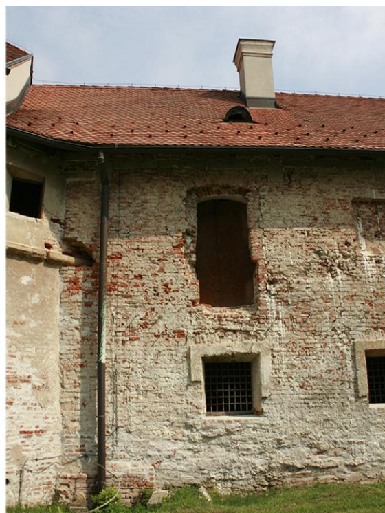
Slika 4.5. Pukotine u zidovima I. i II. dilatacije
