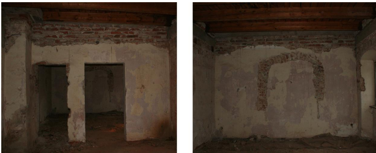
Slika 4.1. Prikaz dva postojeća zida
