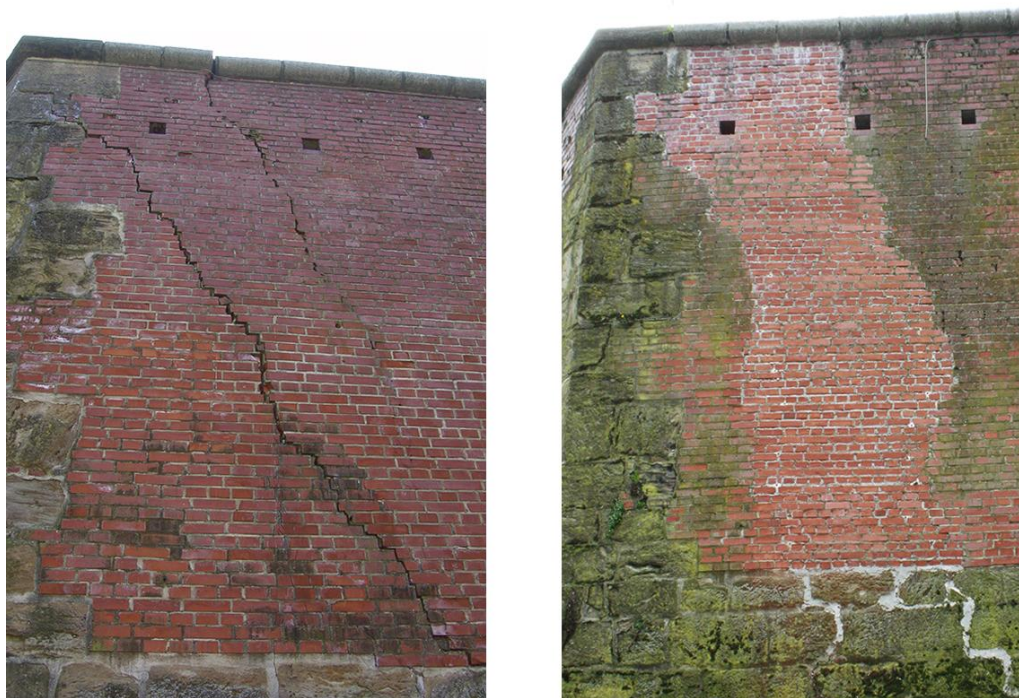
Slika 4.21. Sanacija zida bastiona, 2006. godine
