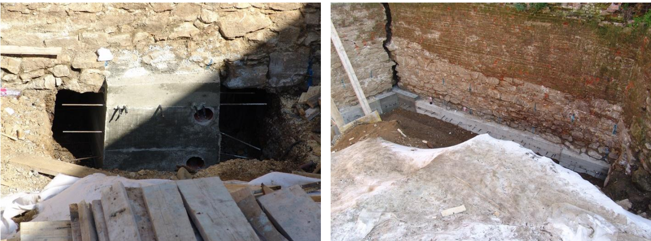
Slika 3.14. Sanacija peterokutnog bastiona
