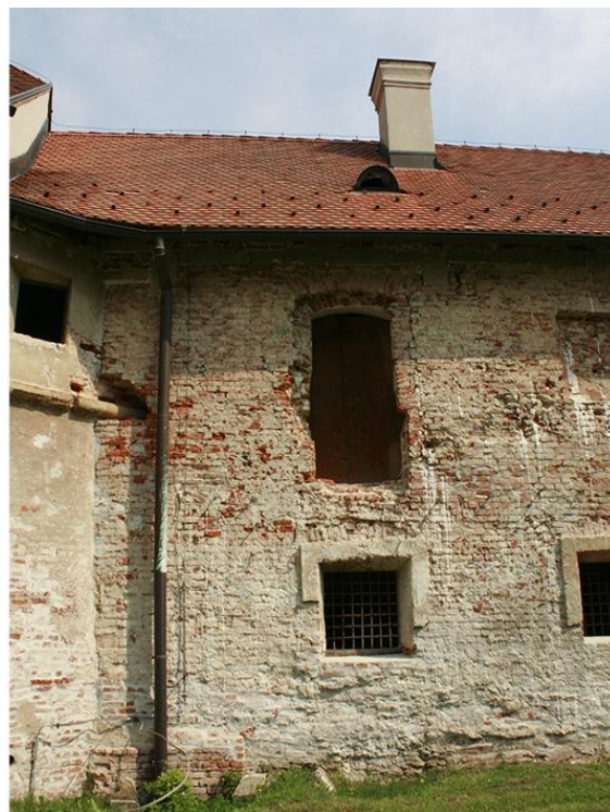
Slika 4.5. Pukotine u zidovima I. i II. dilatacije
