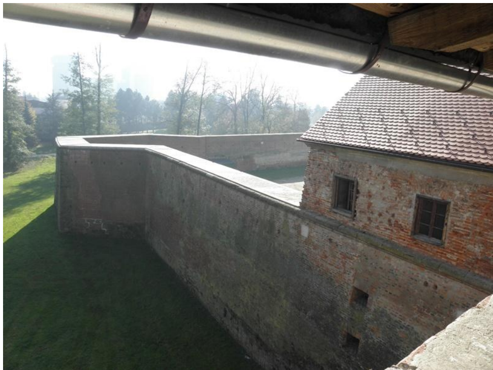
Slika 4.23. II bastion i zid kurtine
