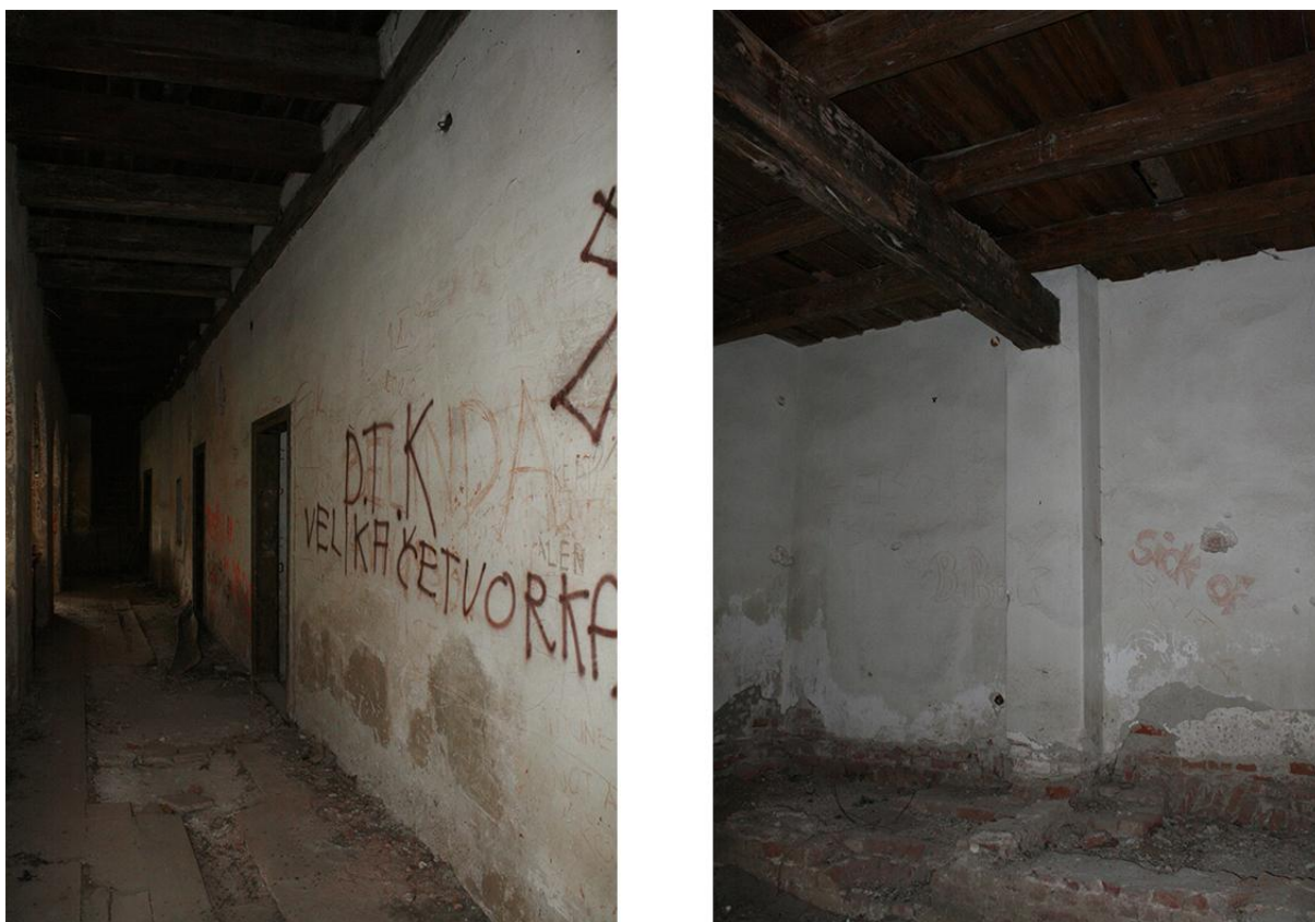
Slika 4.10. Postojeći unutarnji uzdužni zid I. kata
