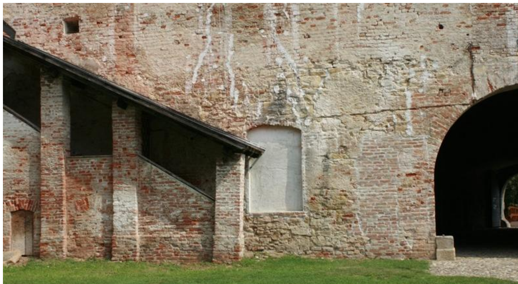
Slika 4.16. Zazidani otvora prozora u prizemlju
