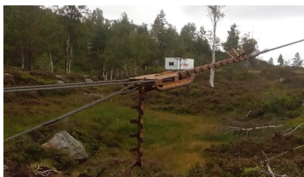
Slika 4.7. Naprava za razvlačenje vodiča - "zmaja"
