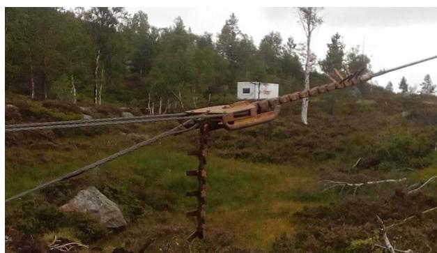
Slika 4.7. Naprava za razvlačenje vodiča - "zmaj"
