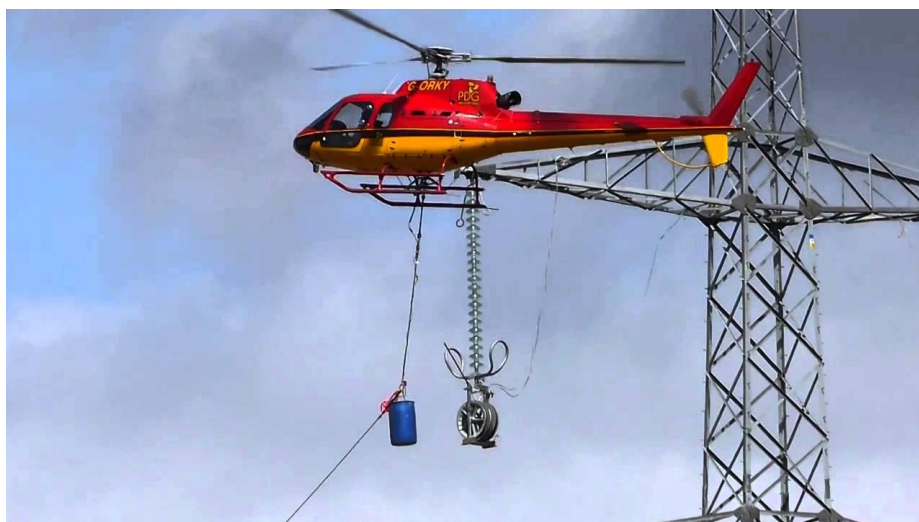
Slika 4.3. Razvlačenje užeta za vanjske faze
