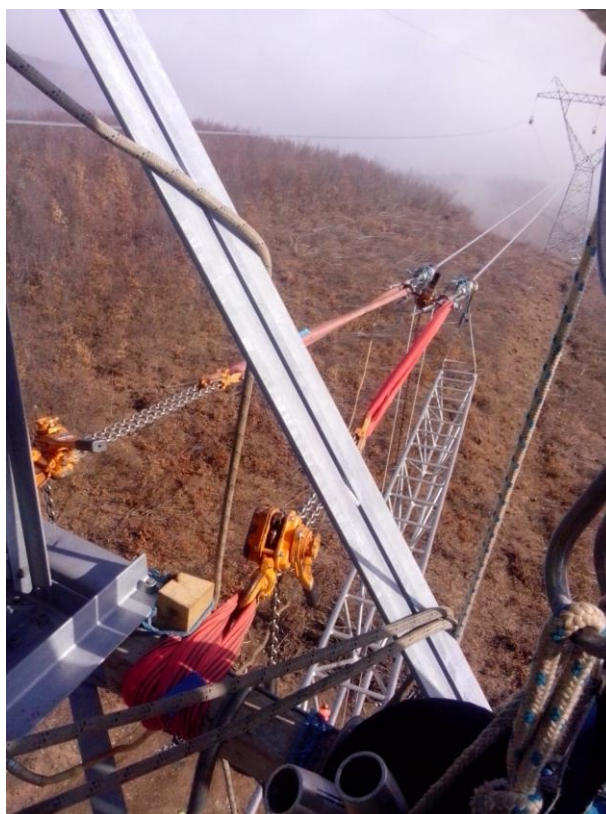
Slika 4.11. Pričvršćivanje vodiča pomoću radne stezaljke na konstrukciju stupa
