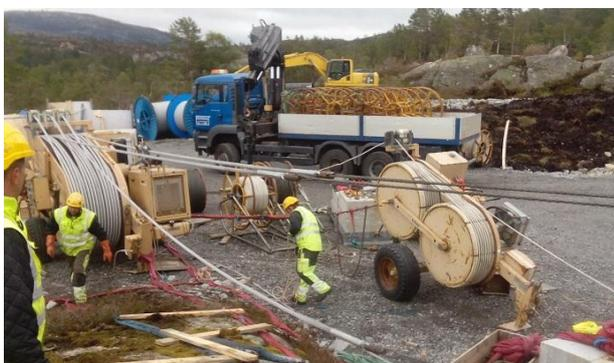
Slika 4.6. Impulzivne početne spojnice za razvlačenje vodiča
