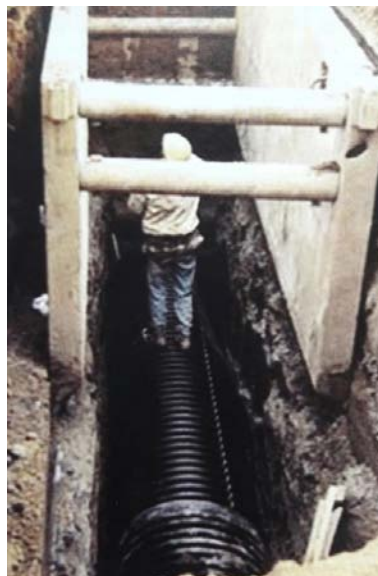
Slika 3.27: Podgrada rova
