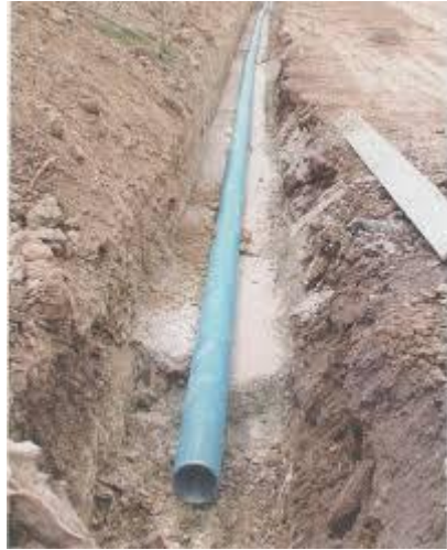
Slika 3.21: Plastična drenažna cijev na podlozi od betona
