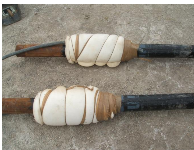
Slika 8.28: Brtva sa spojem čelične i okiten cijevi
