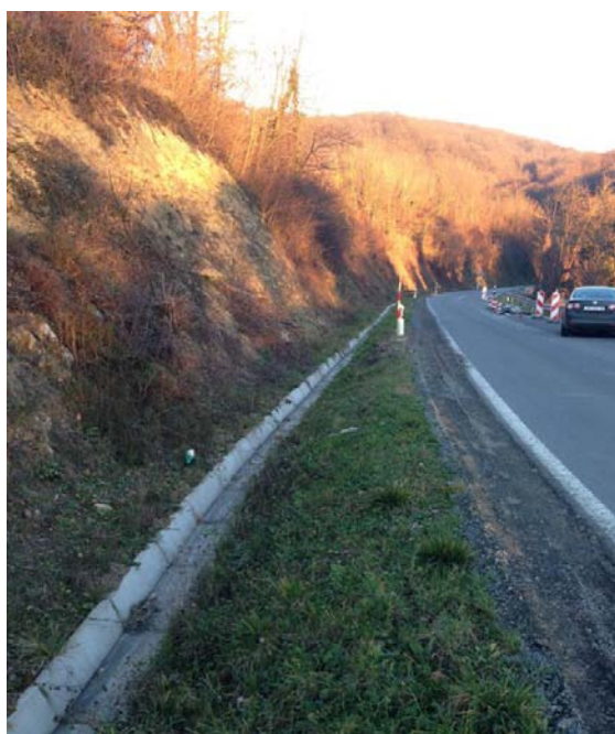
Slika 8.6: Preventivne mjere za uspostavljanje stabilnosti – ublažavanje klizanja izvedene su 2013. godine, odvodnjom vode izgradnjom kanalice uz zasjek, sprečavanjem udara vode na čelo klizišta i pokrivanjem nepropusnom folijom za oborine na klizni segment
