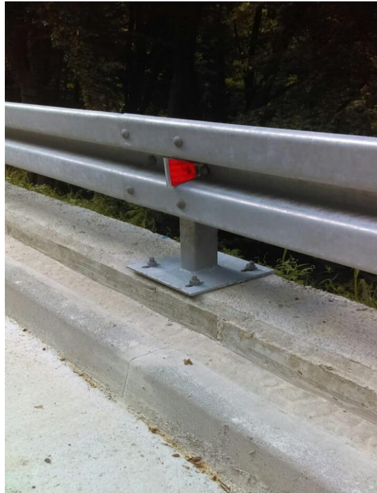
Slika 8.33: Detalj zaštitne ograde - H2 iz priloga P15-1
