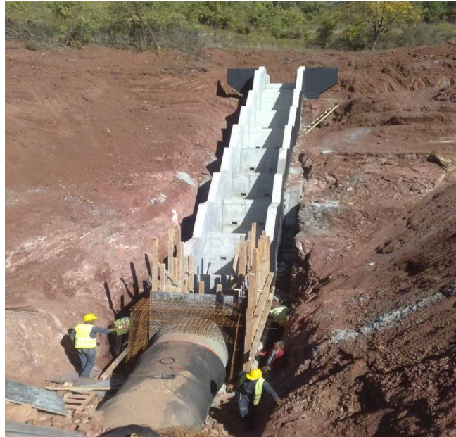
Slika 3.46: Betoniranje kaskade
