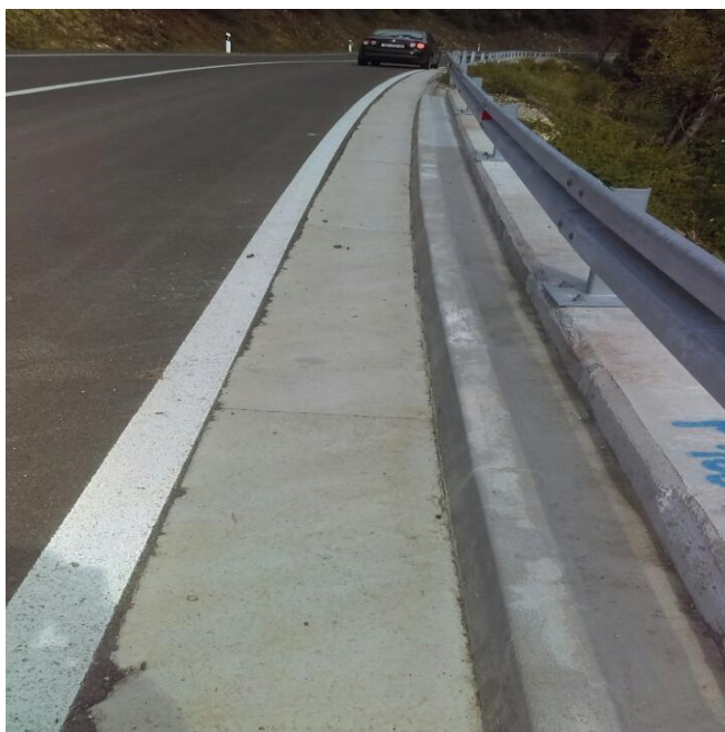
Slika 8.30: Sustav odvodnje površinskih voda (rigol s rubnjakom)
