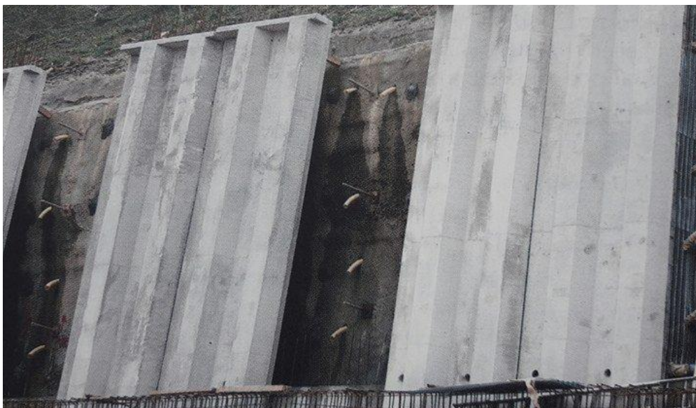
Slika 4.13: Izrada zida u kampadama ( Dragčević, Rukavina 2006. )
