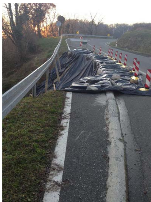
Slika 8.6: Preventivne mjere za uspostavljanje stabilnosti – ublažavanje klizanja izvedene su 2013. godine, odvodnjom vode izgradnjom kanalice uz zasjek, sprečavanjem udara vode na čelo klizišta i pokrivanjem nepropusnom folijom za oborine na klizni segment
