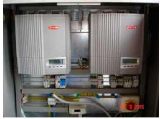
Slika 4.4. Pretvarač, SMA - njemački proizvođač (lijevo), Fronius - austrijski proizvođač (desno) [12]
