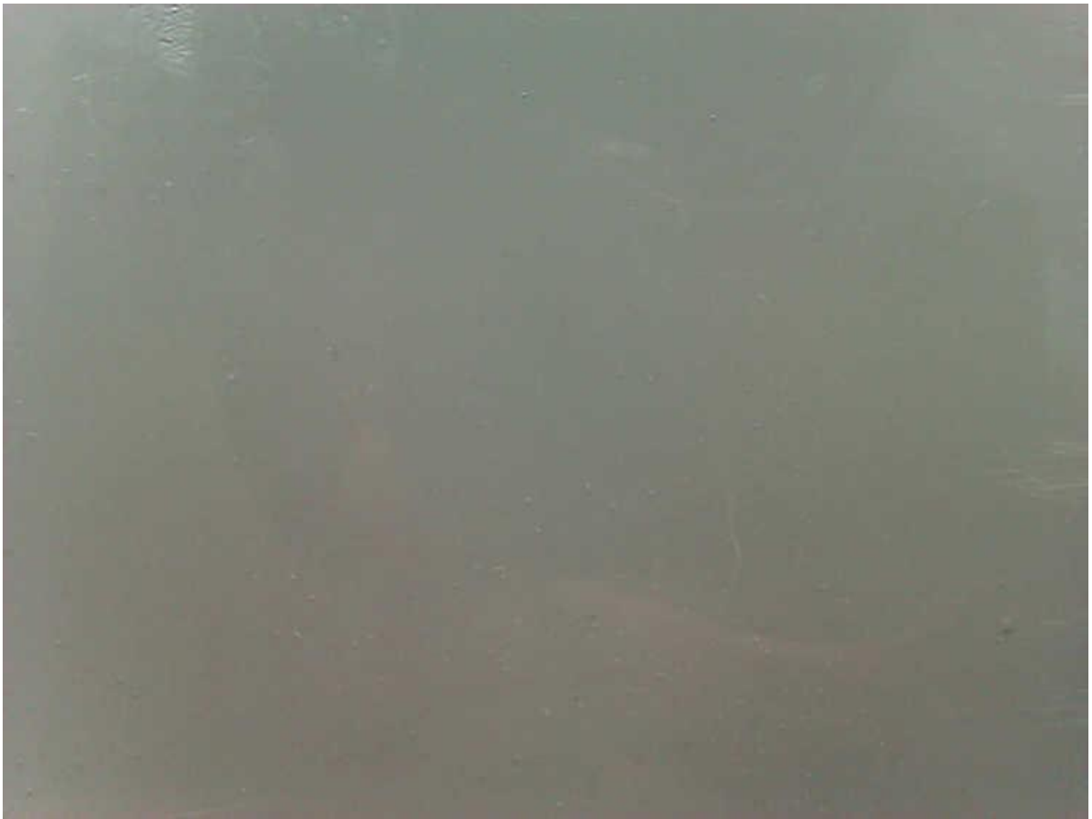
Slika 35 - Nebrušena / neaktivirana premazana površina
