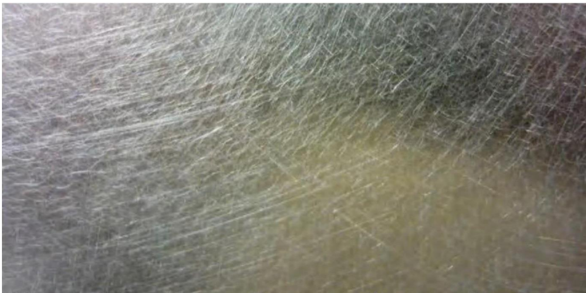
Slika 27 - Pripremljena površina - obrušeno
