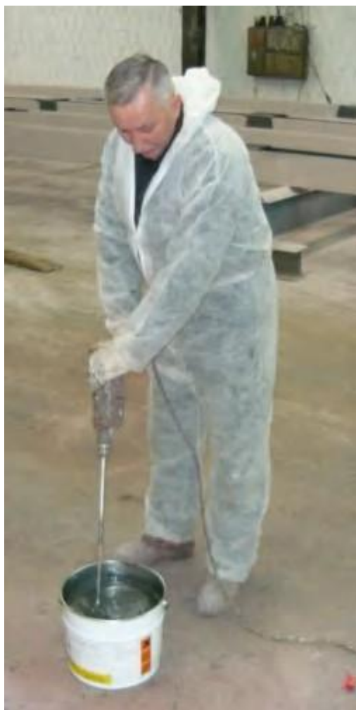
Slika 42 - Pravilno miješanje premaza
