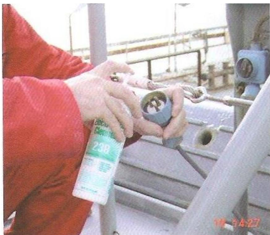
Slika 19 - Zaštita električnih kontakata
