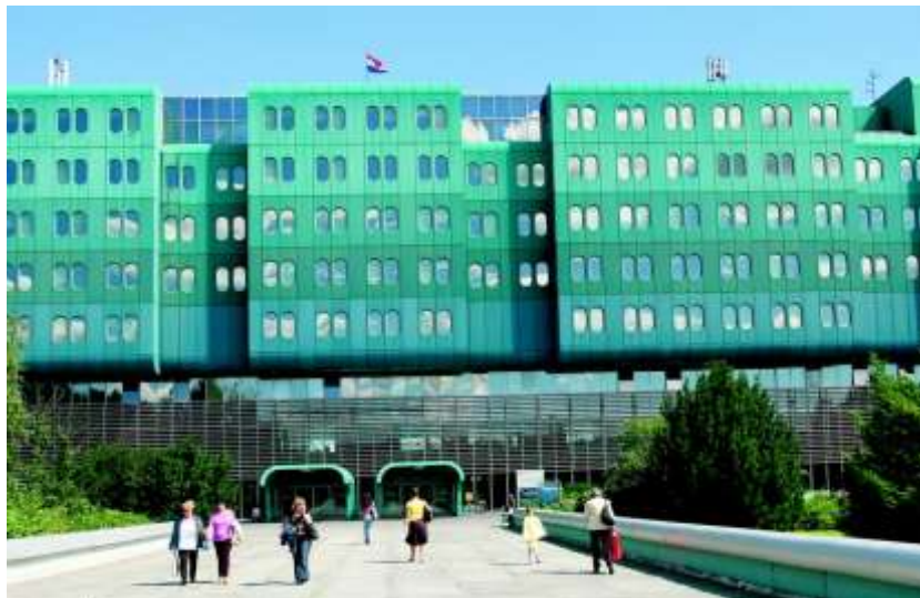
Slika 3.1 Izgled Kliničke bolnice Zagreb izvana
