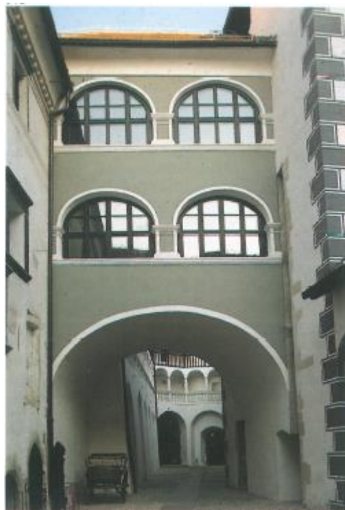
Slika 3.50 Most između gotičke kule i sjevernih zidina
