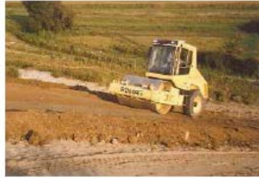
Slika 6.1.5. Kompaktiranje gline (Izvor: Gotal Dmitrović, L. i sur., 2013.)
