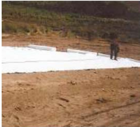
Slika 6.1.2. Postavljanje geotekstila (Izvor: http://www.buic-bas.hr/materijali/7/geotekstili/ )
