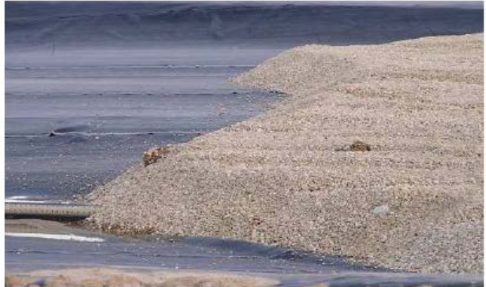
Slika 6.1.3. Postavljanje drenažnog sloja od šljunka (Izvor: Gotal Dmitrović, L. i sur., 2013.)
