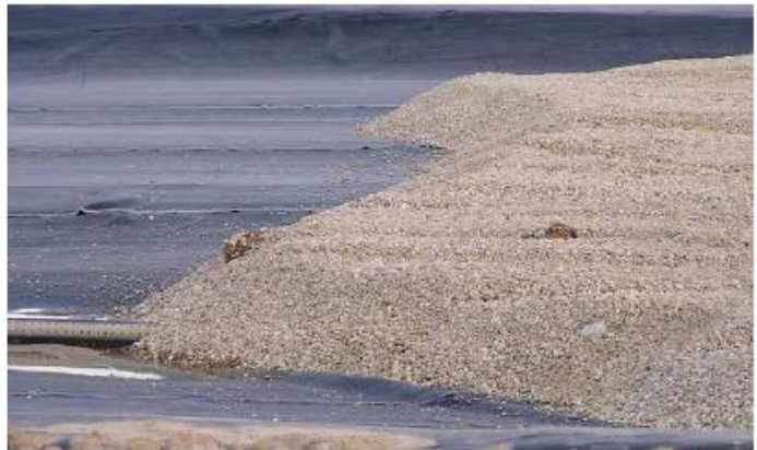
Slika 6.1.3. Postavljanje drenažnog sloja od šljunka (Izvor: Gotal Dmitrović, L. i sur., 2013.)
