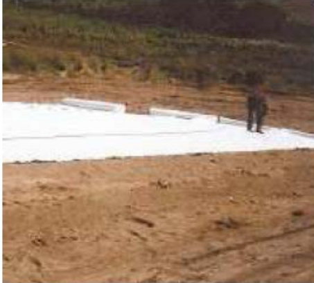
Slika 6.1.2. Postavljanje geotekstila (Izvor: http://www.buic-bas.hr/materijali/7/geotekstili/ )
