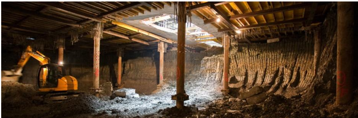
Slika 4. Iskop rova metodom „TOP DOWN“
