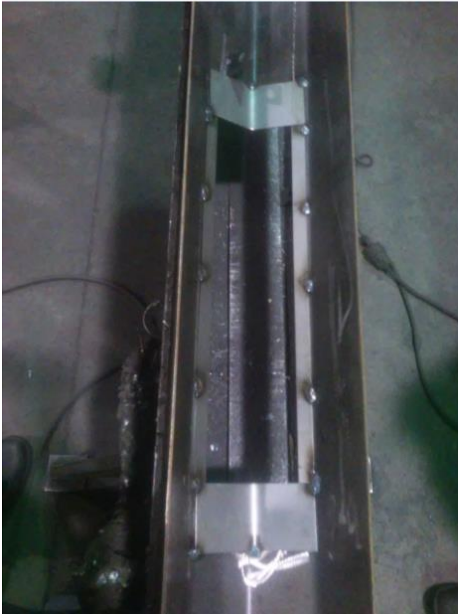
Slika 5.10. Ugradnja elemenata revizionog otvora
