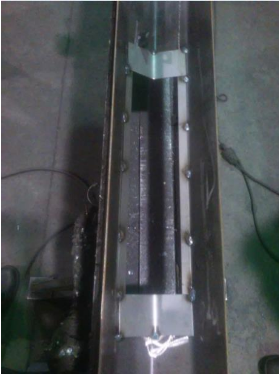
Slika 5.10. Ugradnja elemenata revizionog otvora
