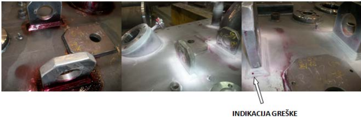
Slika 4.7 Ispitivanje zavarenih spojeva poklopca crvenim penetrantom
