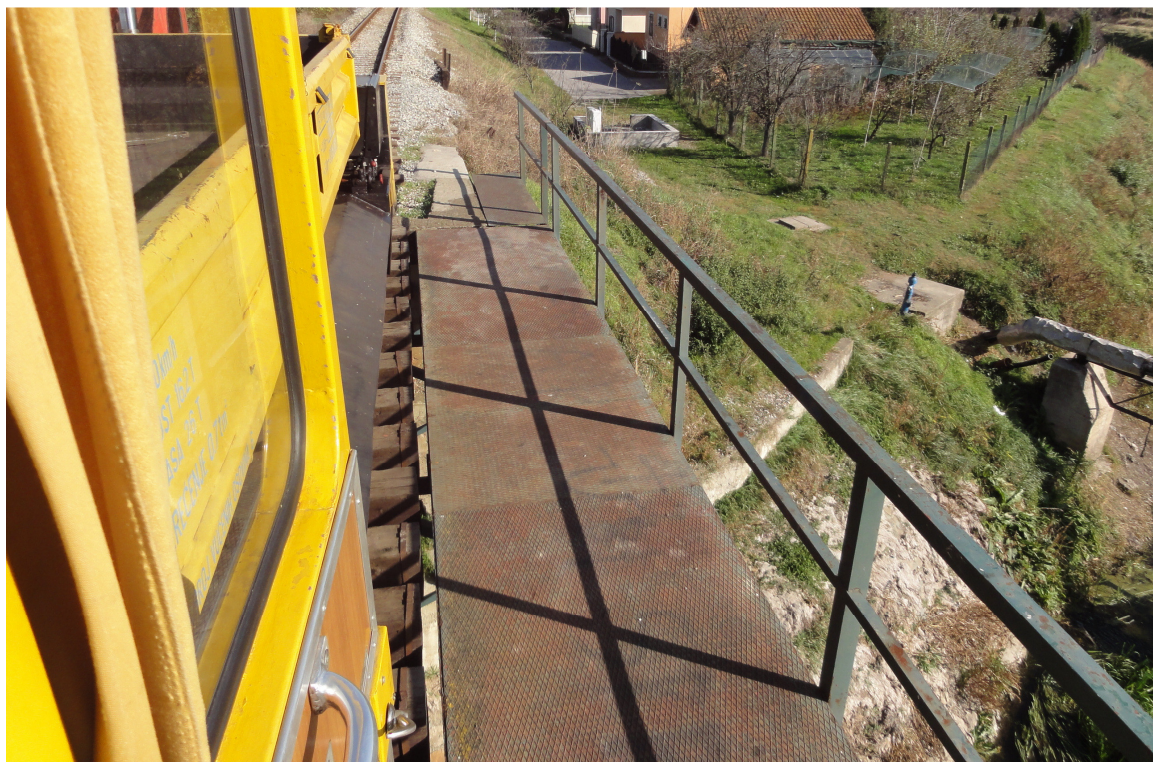
Slika 1.1-3 Čelični most Bobotski kanal (izvor: arhiva ŽPD d.d.)
