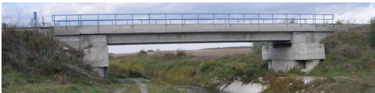
Slika 1.1-2 Armirano-betonski most Vuka (izvor: arhiva ŽPD d.d.)
