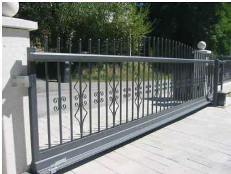
Slika 2.8. Klizna vrata bez vodilice [8]
