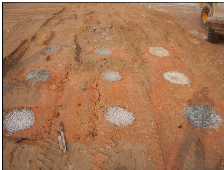
Slika 2.2. Izgled šljunčanih pilota u kvadratnom rasporedu.
